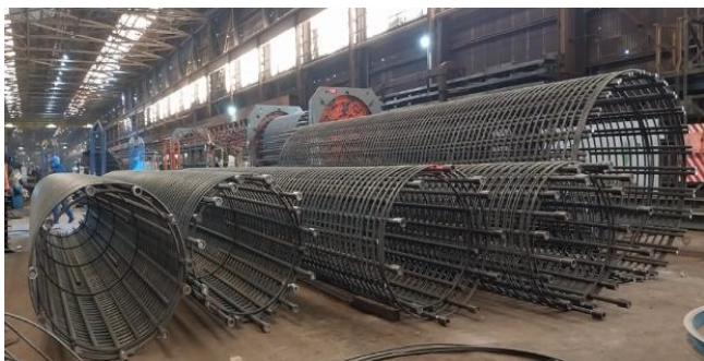
Figura 9. Jaulas prefabricadas de pilote con empalmes mecánicos roscados.
