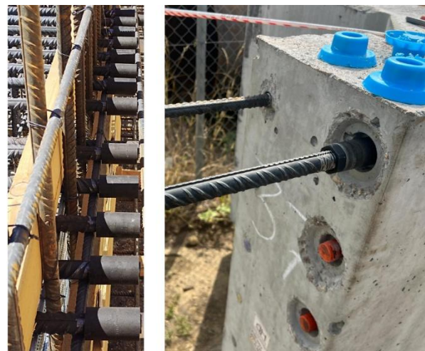
Figura 8. Obra del Soterramiento de la A-5 en Madrid, y Edar Sevilla
