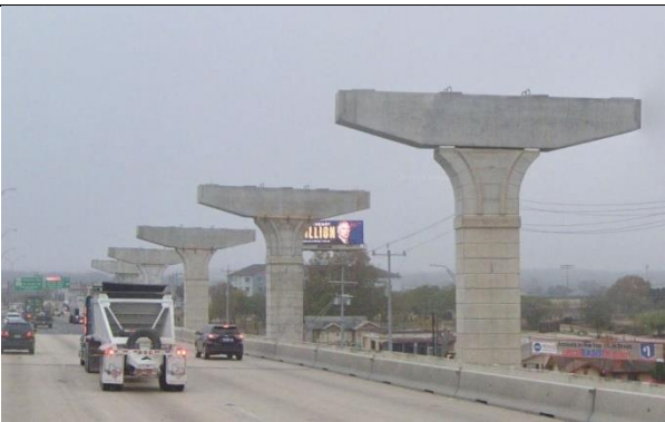
Figura 10. Pilas tipo “hammerhead”.
