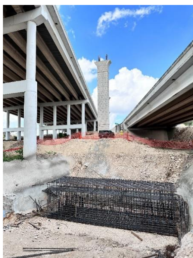
Figura 17. Cimentación compartida para la pila 17 del puente 113B y la columna 2 del "straddle bent" de la pila 8 del puente 114.
