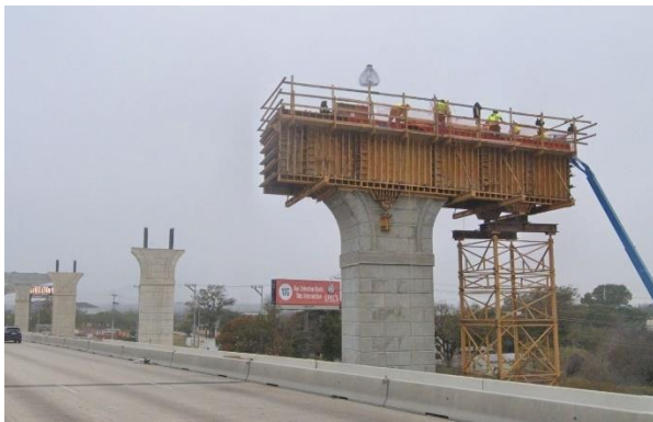
Figura 20. Construcción del cabezal de la pila 17, excéntrica, del puente 113B.
