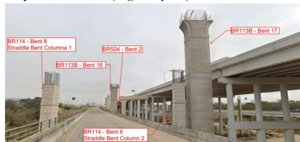
Figura 15. Encaje de las pilas 17 y 18 del puente 113B, de la pila 8 del puente 114 y de la pila 2 del puente 504 (ampliación del puente existente, sobre el Cibolo Creek, de las calzadas principales de la I-35).
