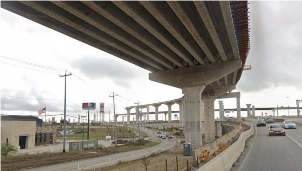
Figura 8. Vista inferior de uno de los tableros.
