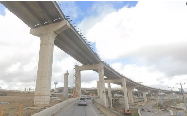
Figura 11. Vista de una pila tipo “straddle bent”.
