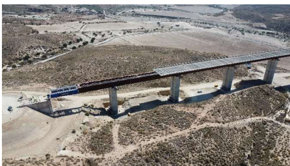
Figura 2. Llegada del tablero al estribo 1.
