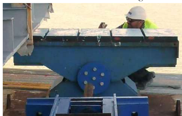
Figura 8. Balancín uniaxial analizado.
