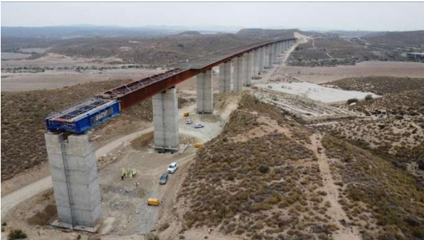
Figura 1. Vista general durante el empuje.
