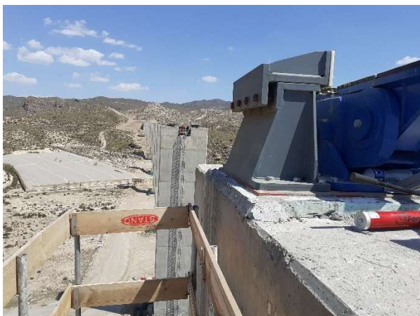
Figura 10. Guidera transversal y balancín.
