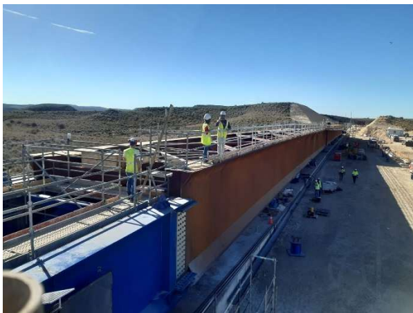
Figura 5. Tablero en el parque de montaje y empuje.
