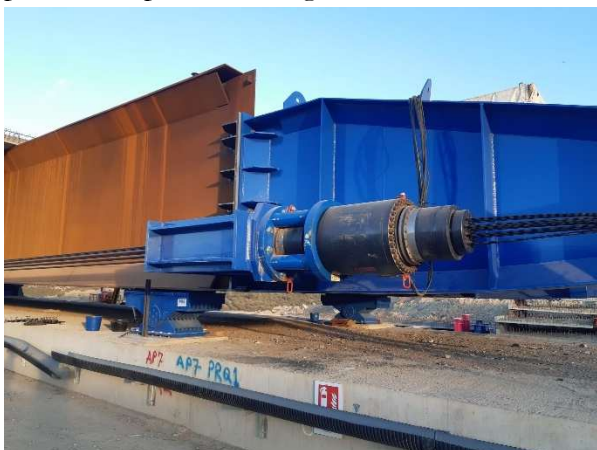
Figura 7. Contranariz en la cola del puente.
