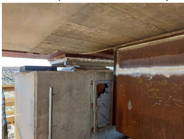
Figura 2. Tope transversal listo para su ajuste.
