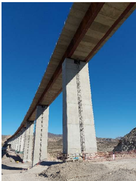
Figura 1. Vista general del viaducto.
