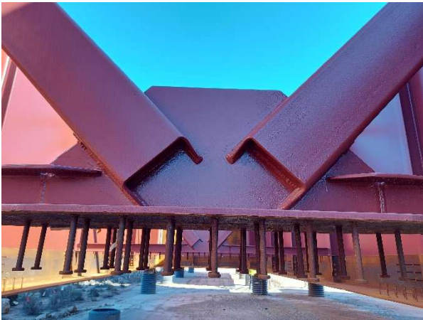
Figura 8. Unión de diagonales a cartelas
