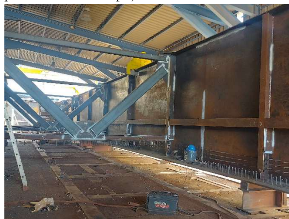
Figura 10. Rigidización de las vigas.
