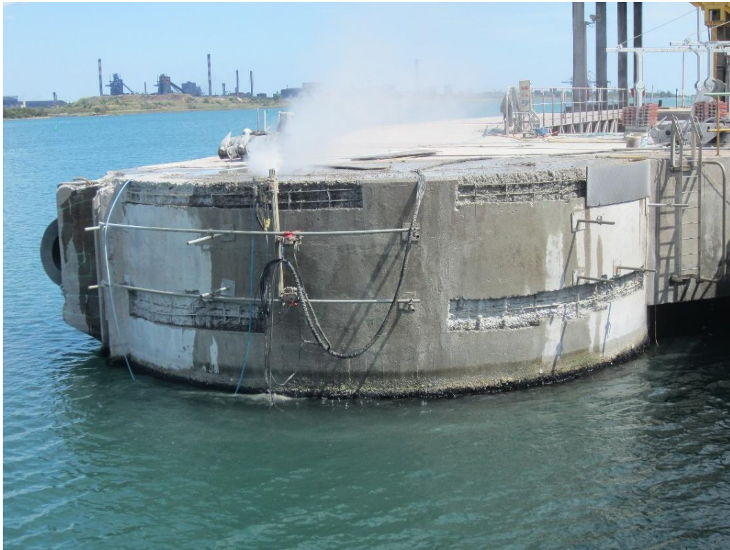
Figura 6. Vista de un robot de hidrodemolición instalado sobre un bastidor metálico que le permite su desplazamiento en las dos direcciones de un paño de reparación previamente definido en la centralita.
