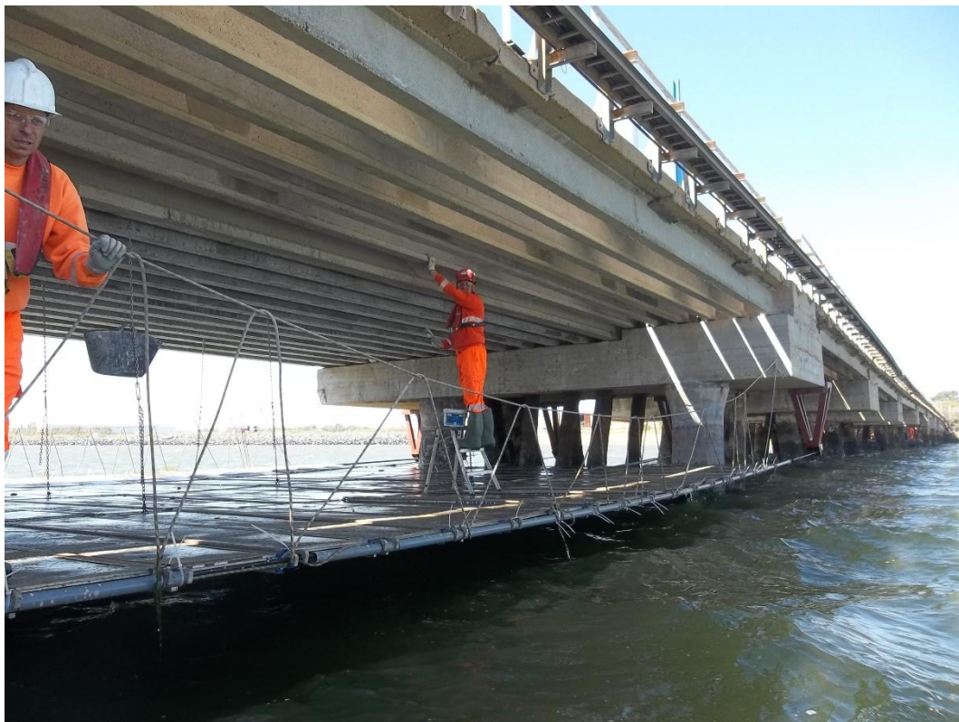
Figura 2. Vista de plataforma de andamio sobre cables portantes en carga, así como de las estructuras auxiliares que permite el anclaje de los tiros de los cables.
