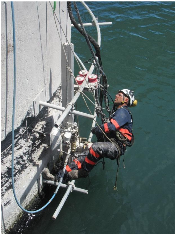
Figura 1. Acceso por cuerdas para fijación de equipos robotizados de hidrodemolición
