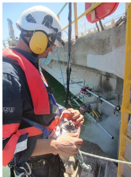
Figura 5. Operador de hidrodemolición robotizada ordenado el equipo a través de centralita remota.
