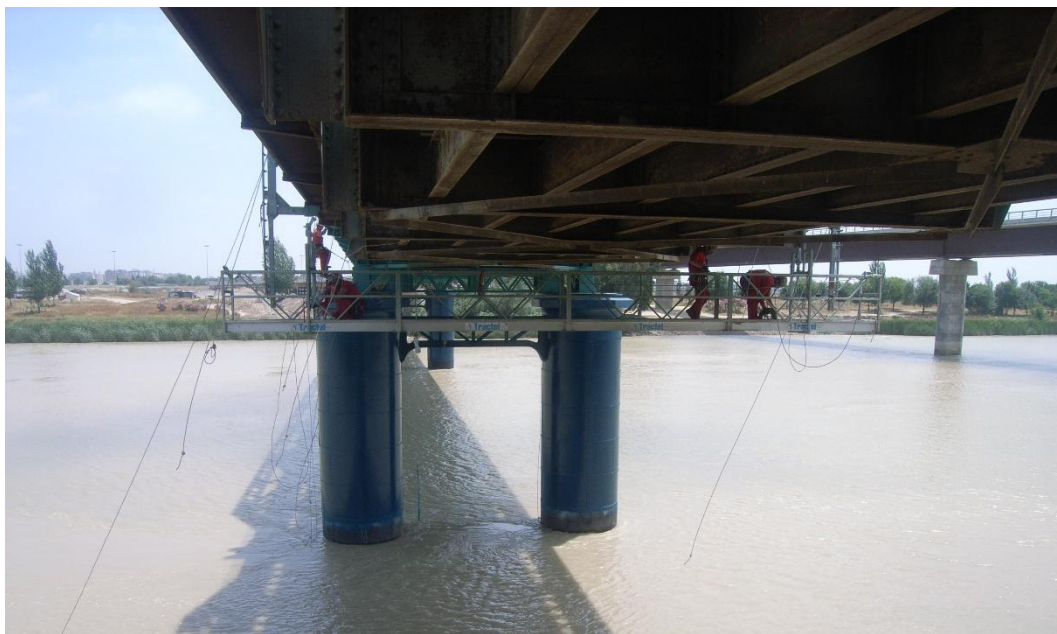
Figura 3. Vista de andamio colgante bajo estructura metálica.
