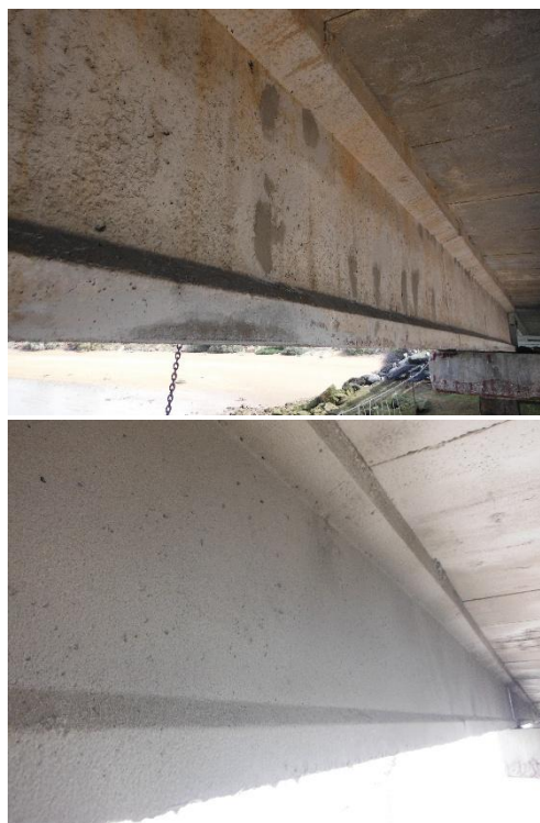
Figura 10. Proceso de aplicación de revestimiento protector
