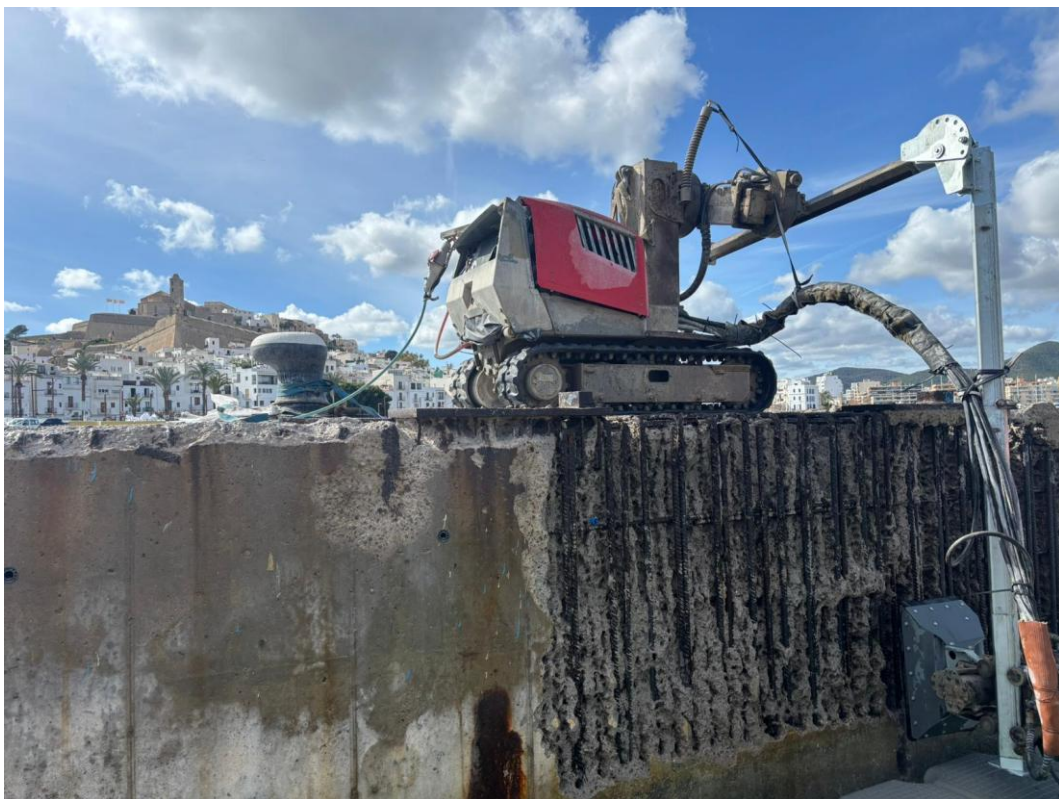
Figura 7. Vista de un robot de hidrodemolición sobre orugas de tipo autopropulsado, que permite la hidrodemolición de paramentos de cualquier tipo en su entorno, incluso en negativo, empleando altos caudales, grandes posibilidades de desplazamiento autónomo y operativa segura.
