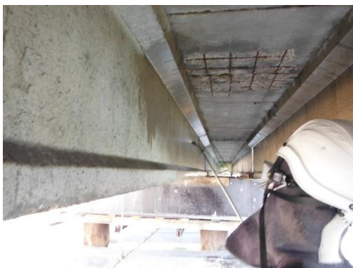
Figura 8. Aplicación de inhibidor de corrosión
