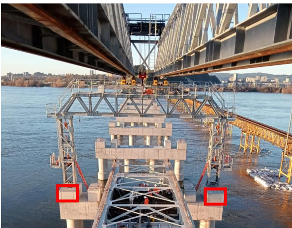
Figura 12. Pórticos anclados en los plintos laterales
