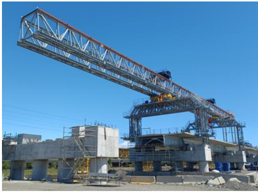
Figura 22. Voladizo lanza-vigas
