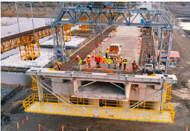
Figura 16. Andamio suspendido para soldadura entre cajones metálicos I
