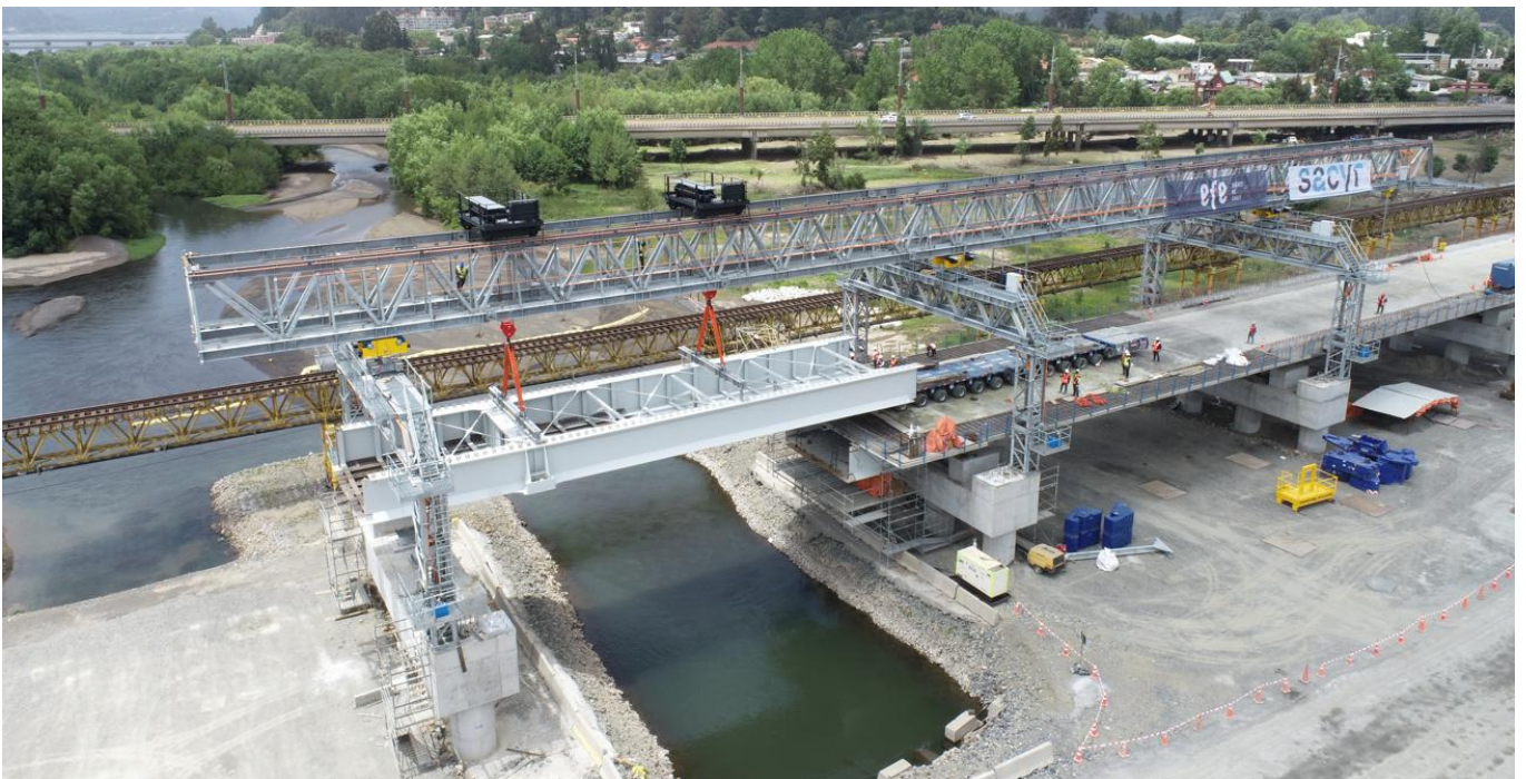
Figura 24. Montaje primer tramo cajón metálico con lanza-vigas
