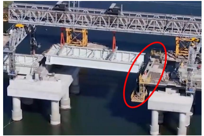
Figura 17. Andamio suspendido para soldadura entre cajones metálicos II
