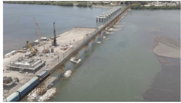
Figura 8. Ejecución de pilotes-cepas sobre península
