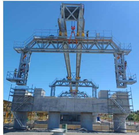
Figura 23. Colocación pórtico delantero lanza-vigas
