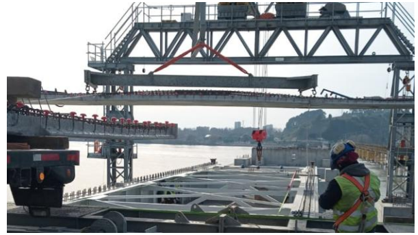
Figura 13. Colocación prelosas con el lanza-vigas
