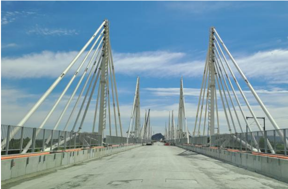
Figura 15. Montaje Estructura Ornamental
