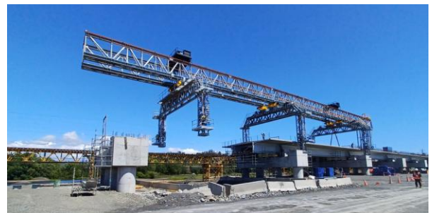
Figura 14. Avance del Pórtico Delantero
