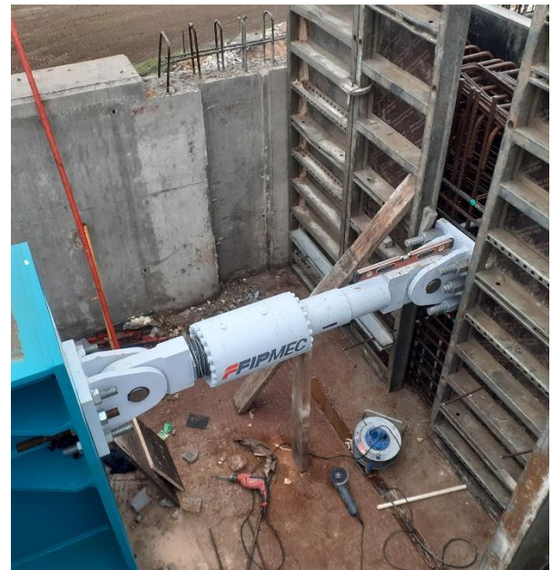
Figura 4. Amortiguadores FVD
