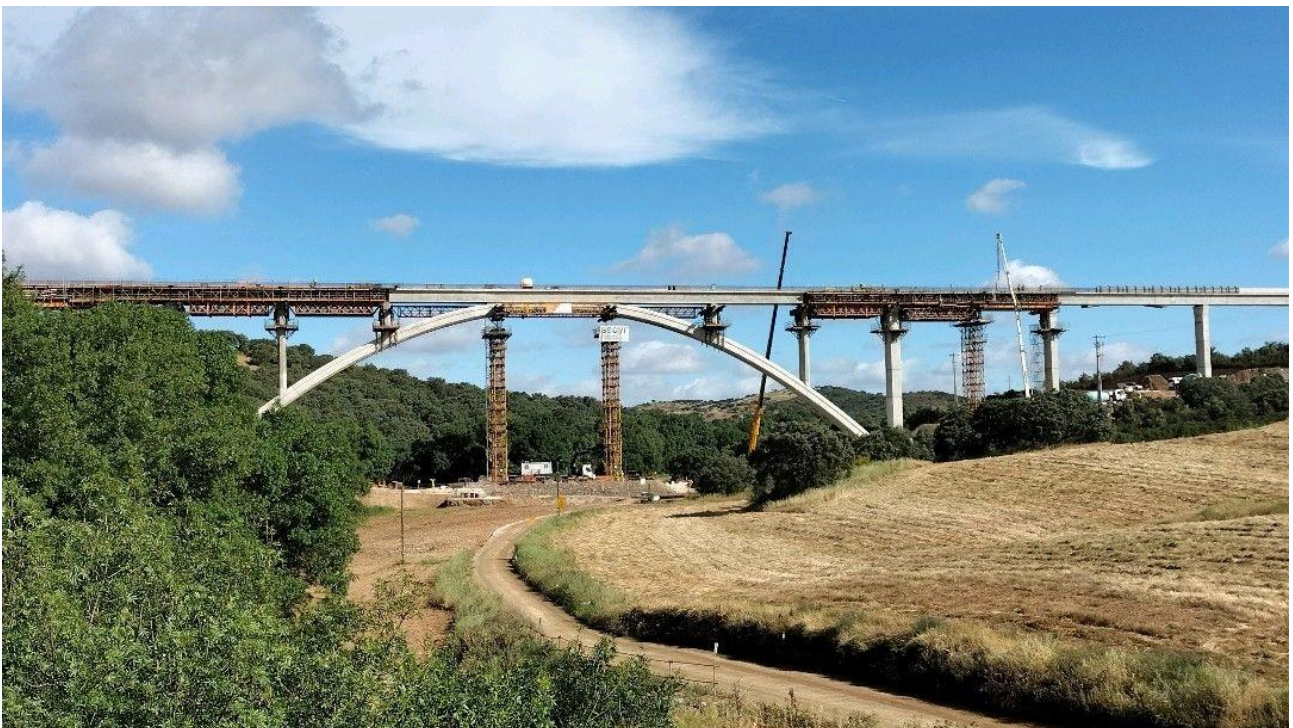
Figura 15. Puente de Pardais durante su última fase de ejecución
