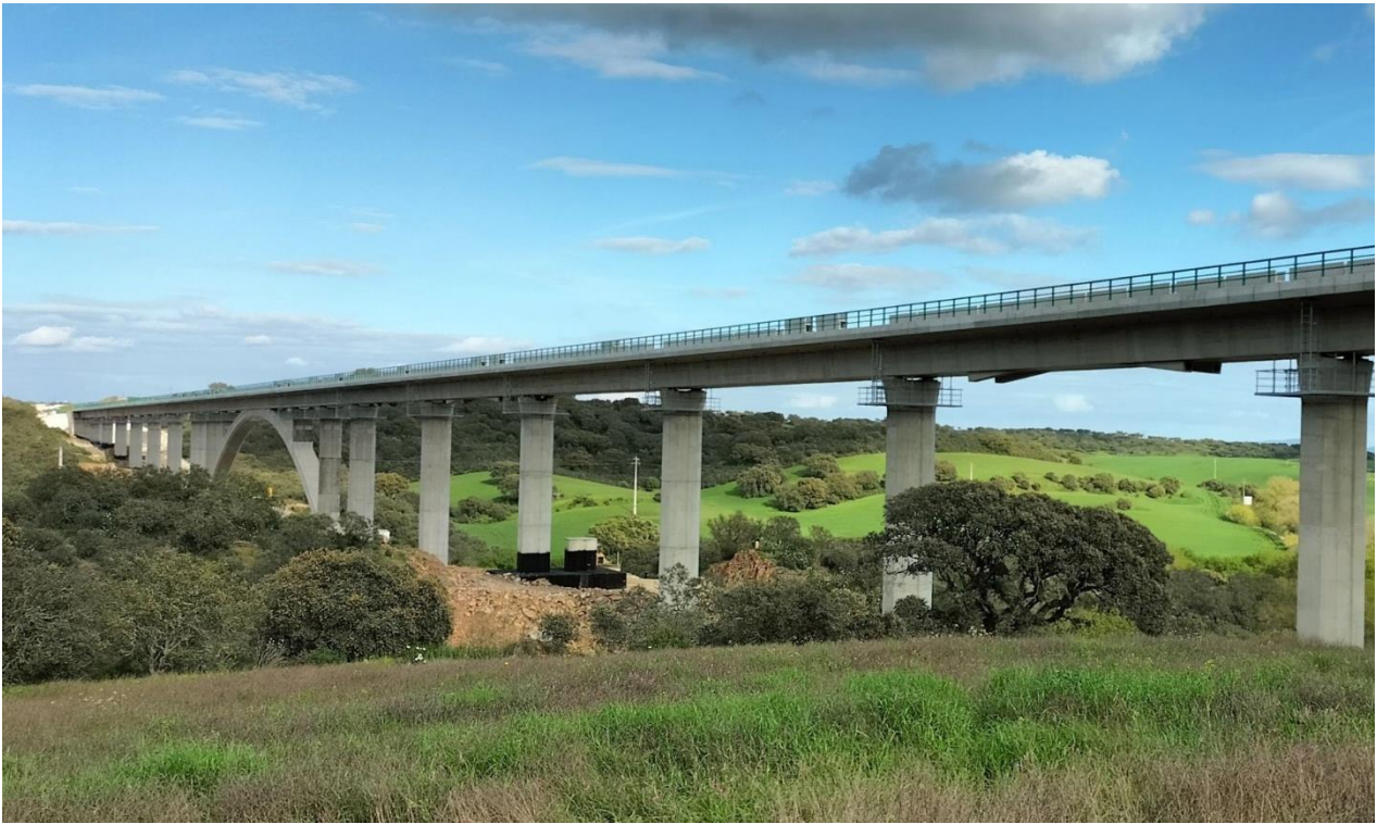
Figura 16. Puente de Pardais finalizado.
