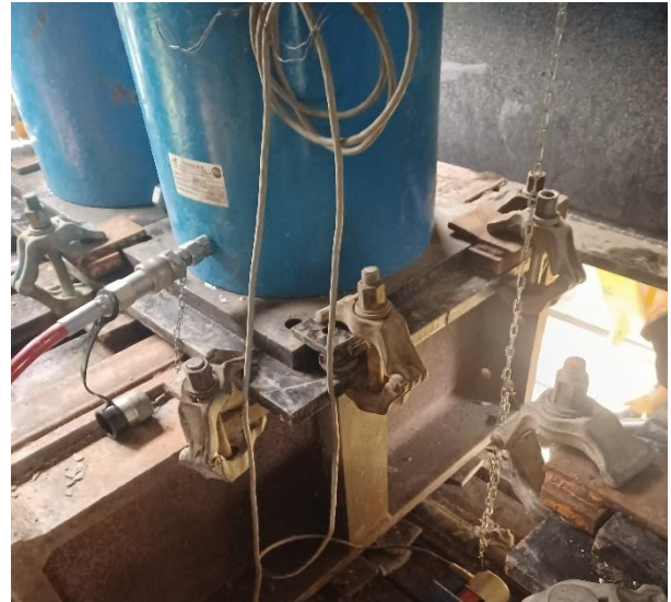
Figura 12. Distanciómetro en pilas (ver cadena a la derecha)
