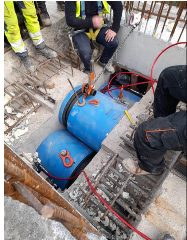
Figura 9. Gatos accionados en la clave del arco
