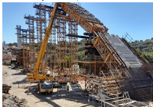
Figura 7. Torres para el cimbrado del arco y encofrado del arranque de un semiarco
