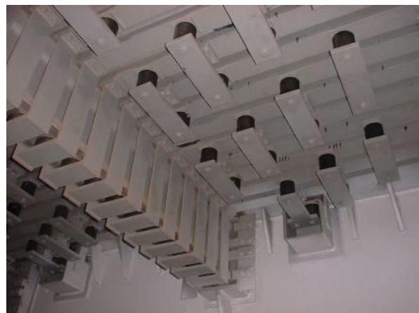
Figura 1. Una junta de dilatación Tensa-Modular vista desde abajo.
