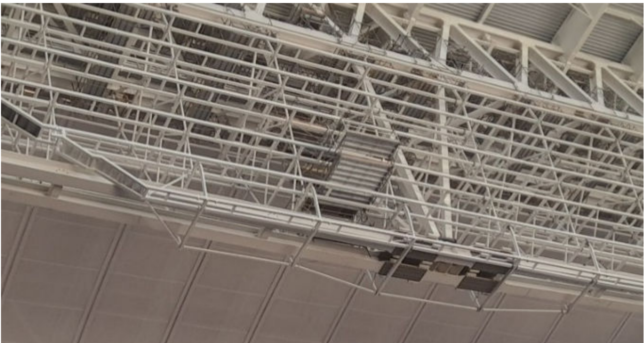
Figura 5. Estructura de fondos envolviendo al tirante de la cercha de cubierta.
