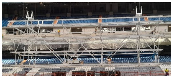
Figura 15. Módulo 2 durante la construcción.
