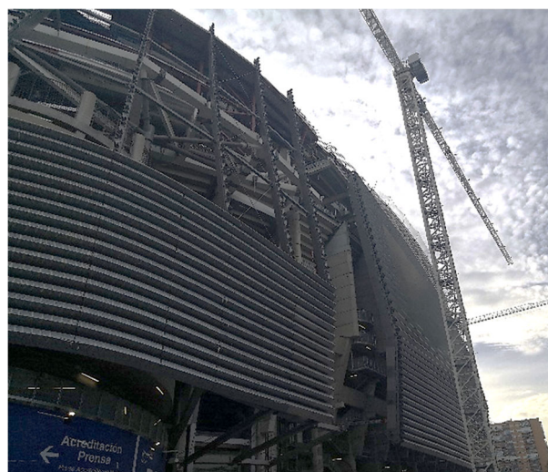
Figura 4. Vista de subestructura de fachada del torreón durante la construcción
