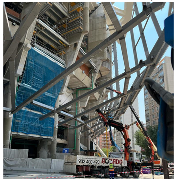
Figura 18. Detalle de estructura de sofito junto a torre
