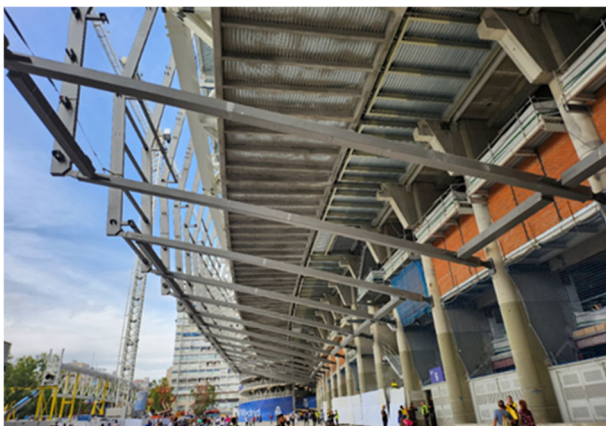
Figura 17. Puntales de sofito Oeste. Montaje parcial, previamente a la colocación de arriostramientos en su plano
