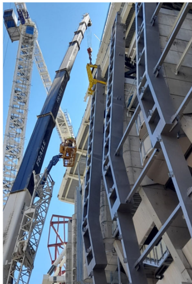
Figura 11. Izado de costillas “diapasón”
