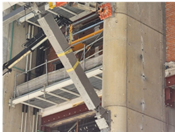
Figura 12. Detalle de conexión de puntales de sofito
