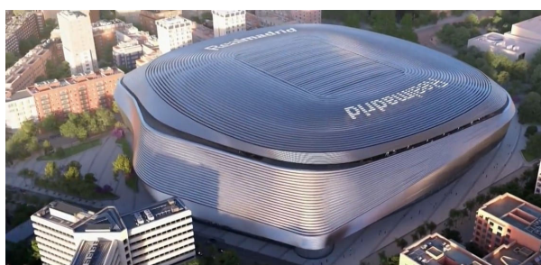
Figura 2. Fachada. Vista desde el Nor-Este. (Copyright © 2024 Nuevo Estadio Bernabéu)
