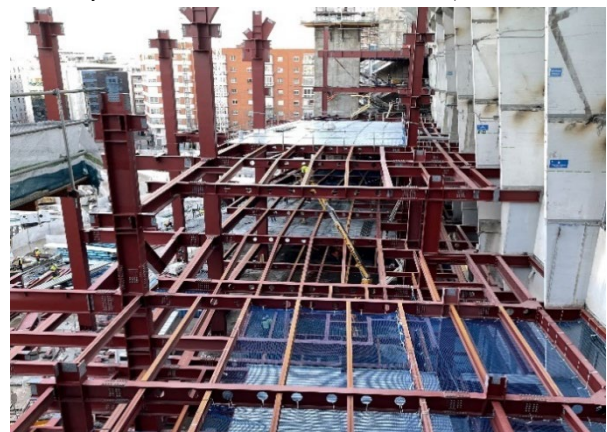
Figura 2. Vigas principales y correas de forjado
