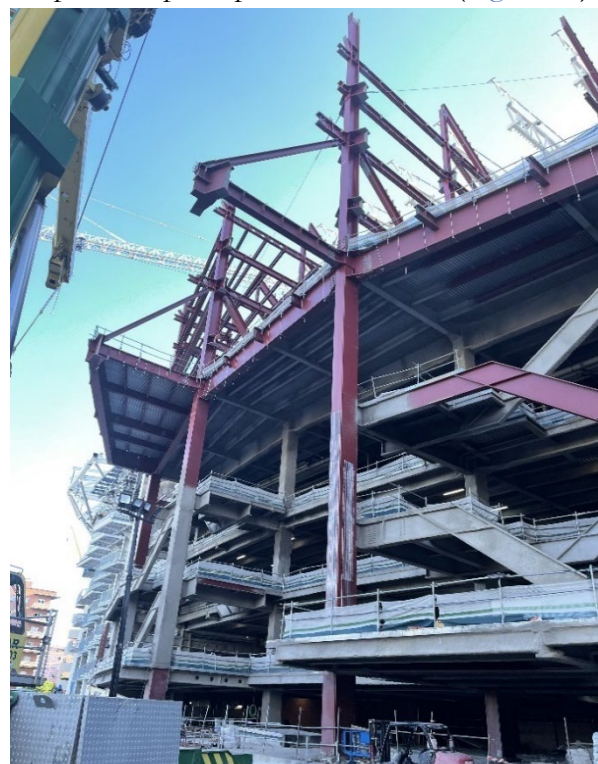
Figura 10. Tirantes de cuelgue de forjado
