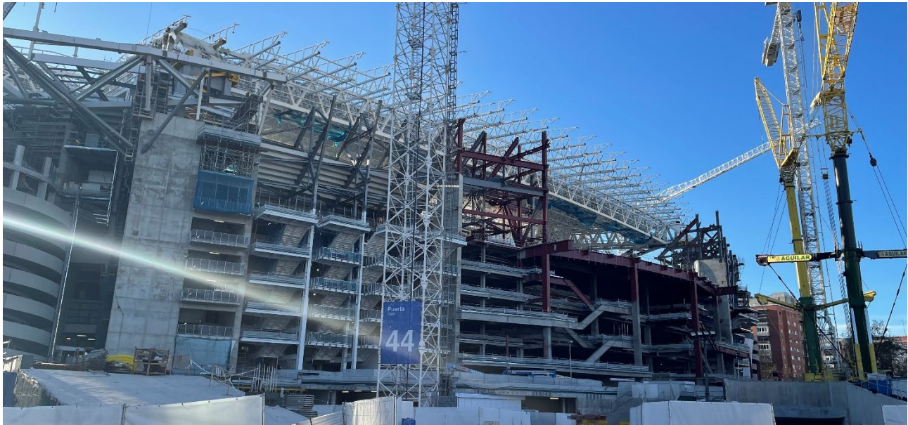
Figura 1. Vista general del Edificio Este durante la construcción
