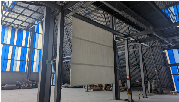
Figura 13. Fotografía de los ensayos de vibración libre en la muestra de 3.5 m x 3.5 m.
