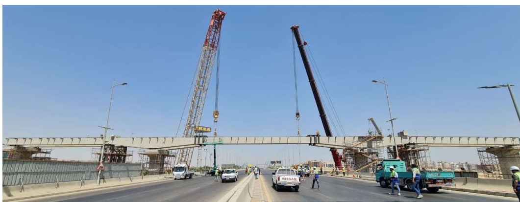
Figura 5. Viaducto continuo en construcción. Línea 6 de octubre
