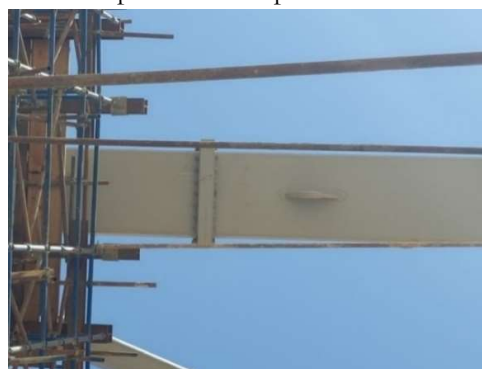
Figura 16. Unión de arcos con chapa a testa
