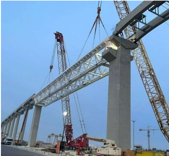
Figura 8. Pila con dintel a doble altura
