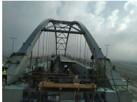
Figura 21. Tesado vigas de rodaje.
