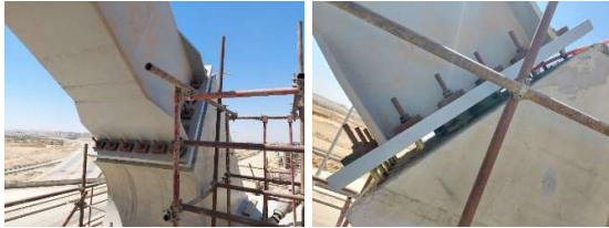
Figura 17. Conexión arco-hormigón
