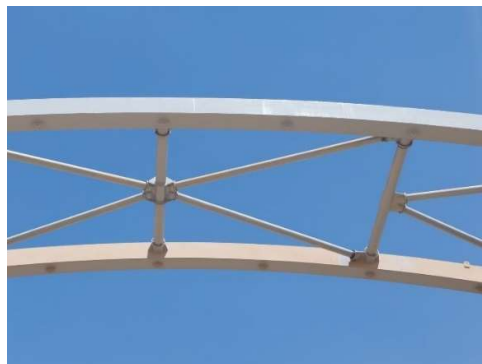
Figura 15. Arriostramientos (péndolas aún sin colocar)
