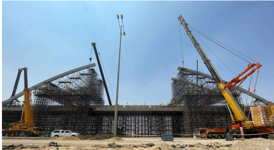
Figura 20. Colocación de arcos
