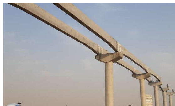
Figura 2. Estructura convencional en construcción. Línea NCC
