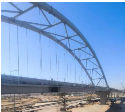
Figura 14. Vista general de la estructura
