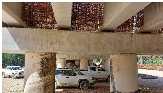
Figura 6. Vigas sobre apoyos temporales con ferralla de riostra preparada para el hormigonado
