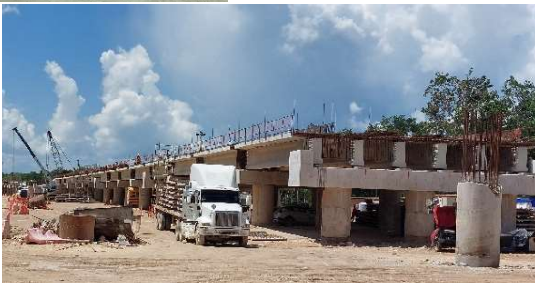
Figura 17. Trabajos en tablero
