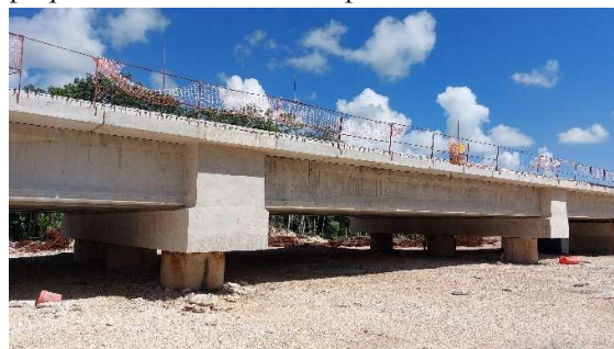
Figura 11. Tramo de altura mínima
