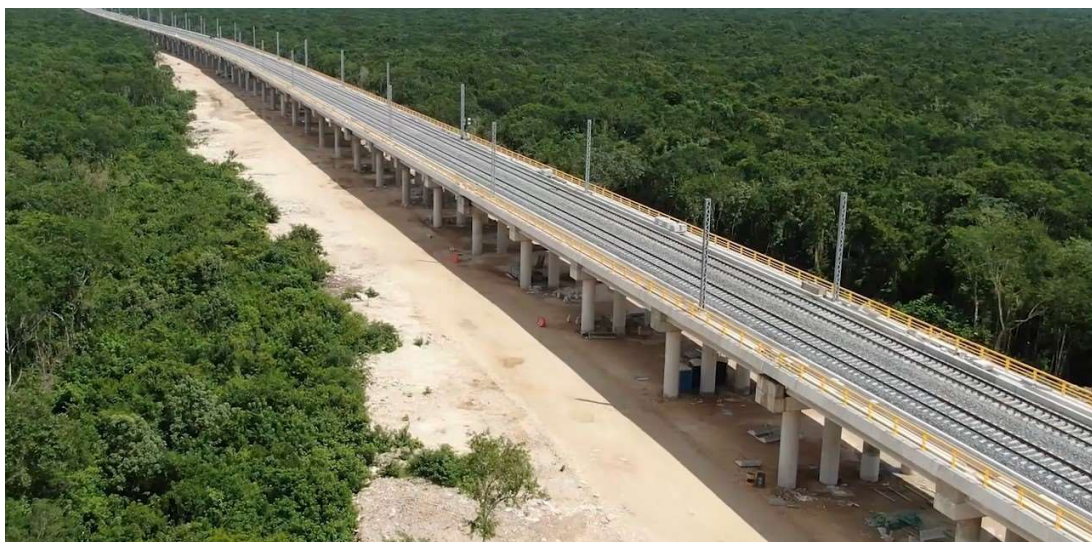
Figura 17. Vista aérea de la obra terminada
