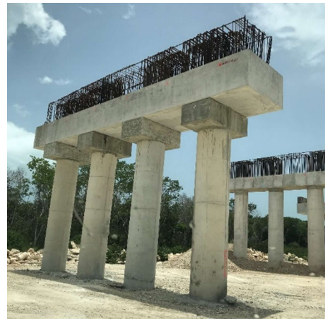
Figura 15. Pilotes y capiteles
