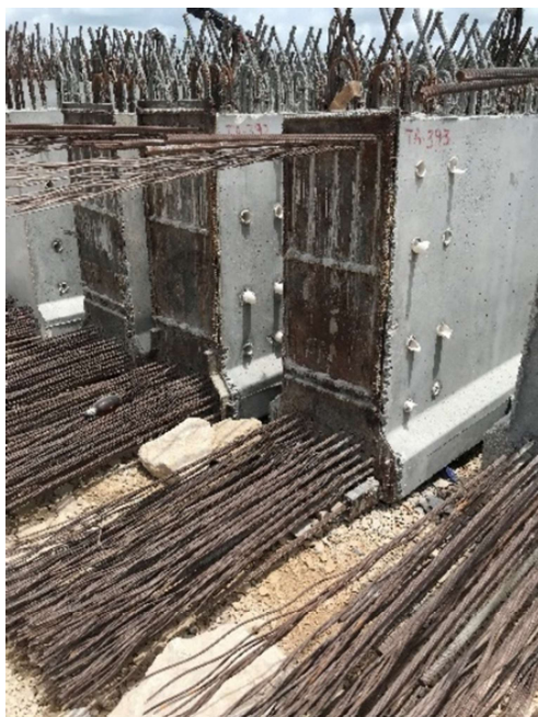
Figura 5. Vigas prefabricadas en parque
