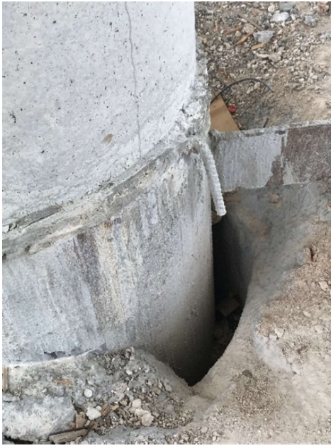
Figura 13. Pilote construido con sobre-excavación
