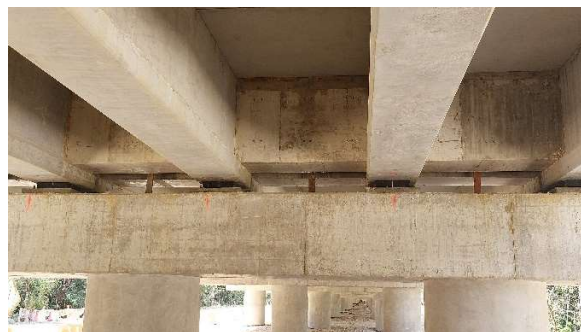
Figura 7. Apoyo en zona de junta
