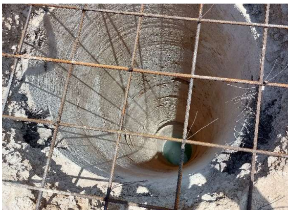
Figura 10. Perforación de un pilote
