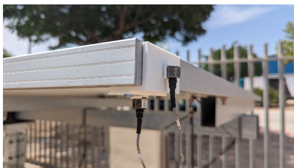
Figura 4. Fotografía del detalle de la disposición de acelerómetros en el seguidor solar.
