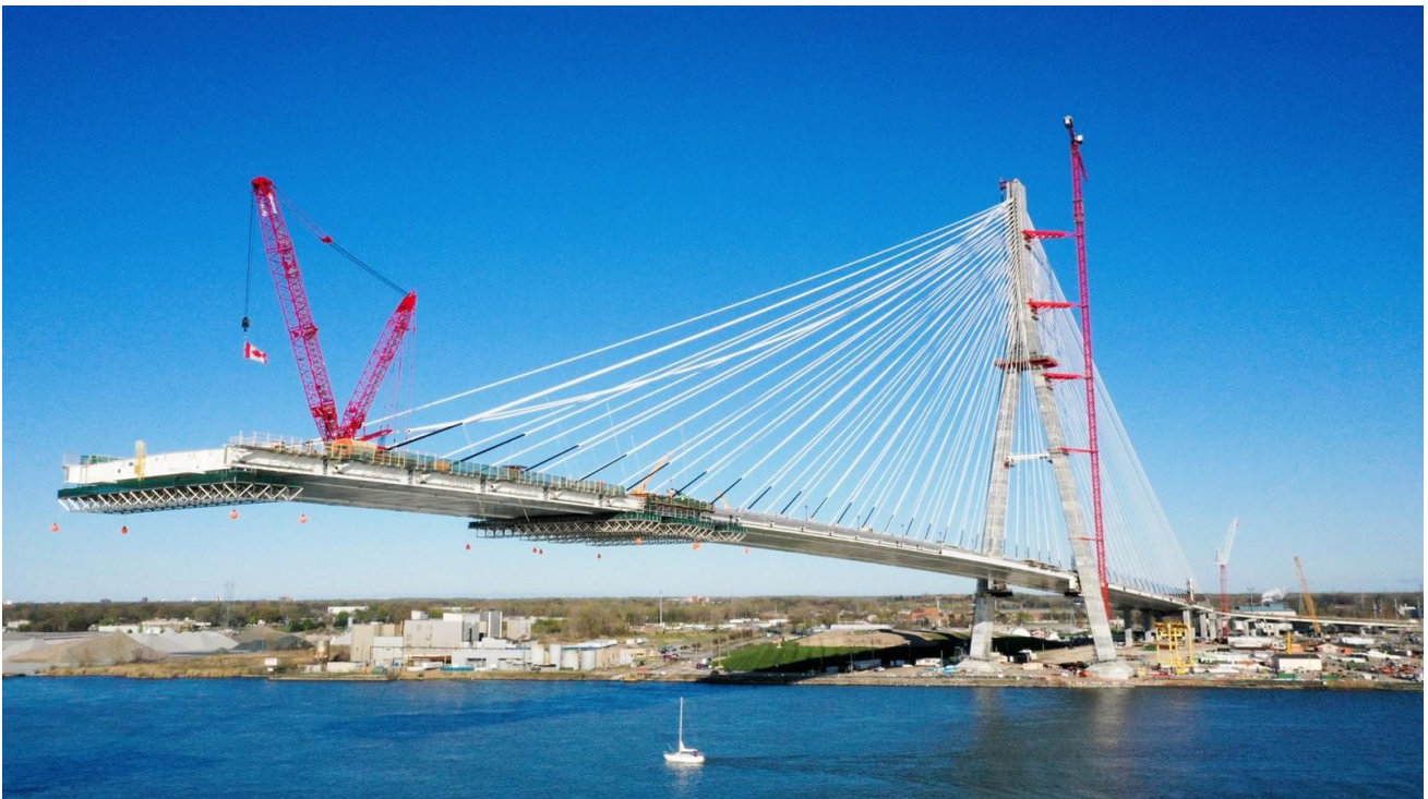
Figura 7. Fase de instalación del tirante del vano central.
