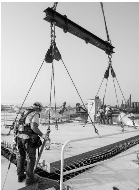
Figura 14. Instalación de panel en obra.
