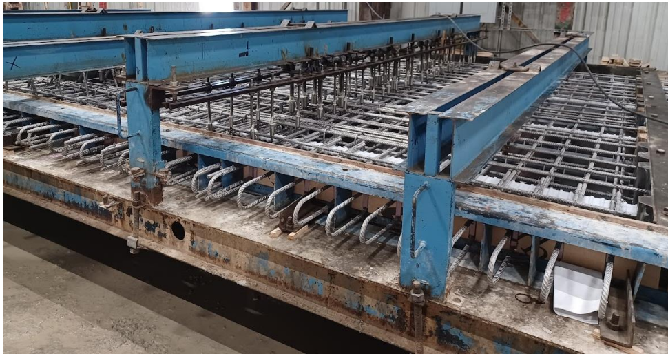
Figura 13. Sistema de encofrado “flexible”.
