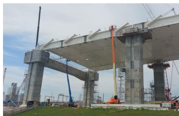
Figura 12. Vista de las pilas 15 (izquierda) y 14 (derecha) durante la construcción de la estructura metálica
