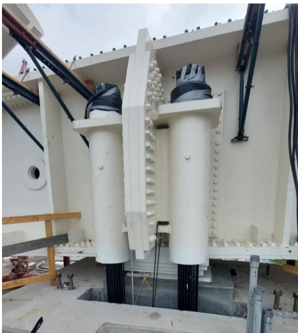
Figura 14. Cables de retenida sobre P12 en proceso
