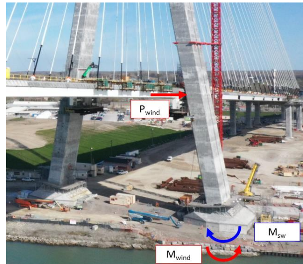
Figura 9. Momentos debidos a tope transversal – Fotografía © WDBA [5]
