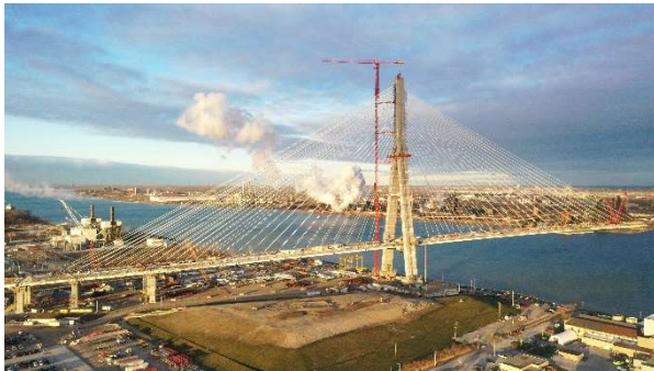
Figura 2. Alzado del puente en construcción, lado Canadá
