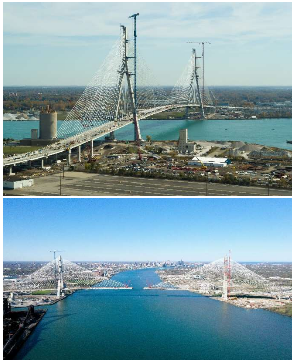
Figura 1. Alzados del puente terminado y en construcción
