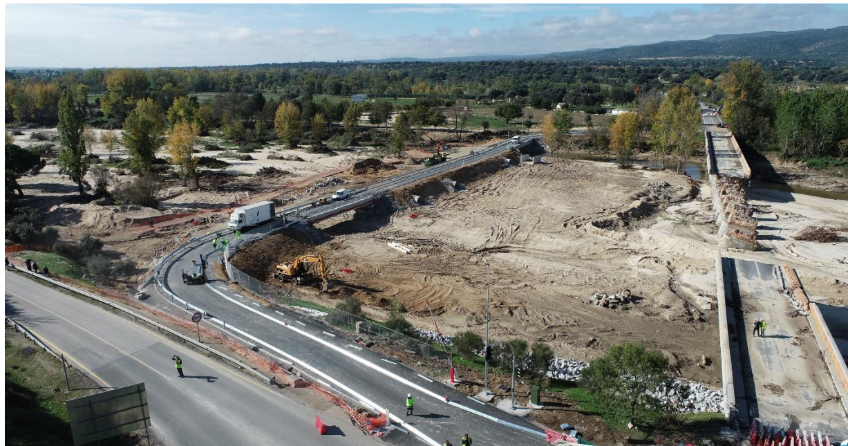
Figura 2. Proceso de construcción del desvío provisional de la carretera M-507.
