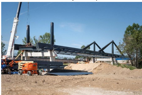
Figura 5. Montaje de tablero metálico en obra.
