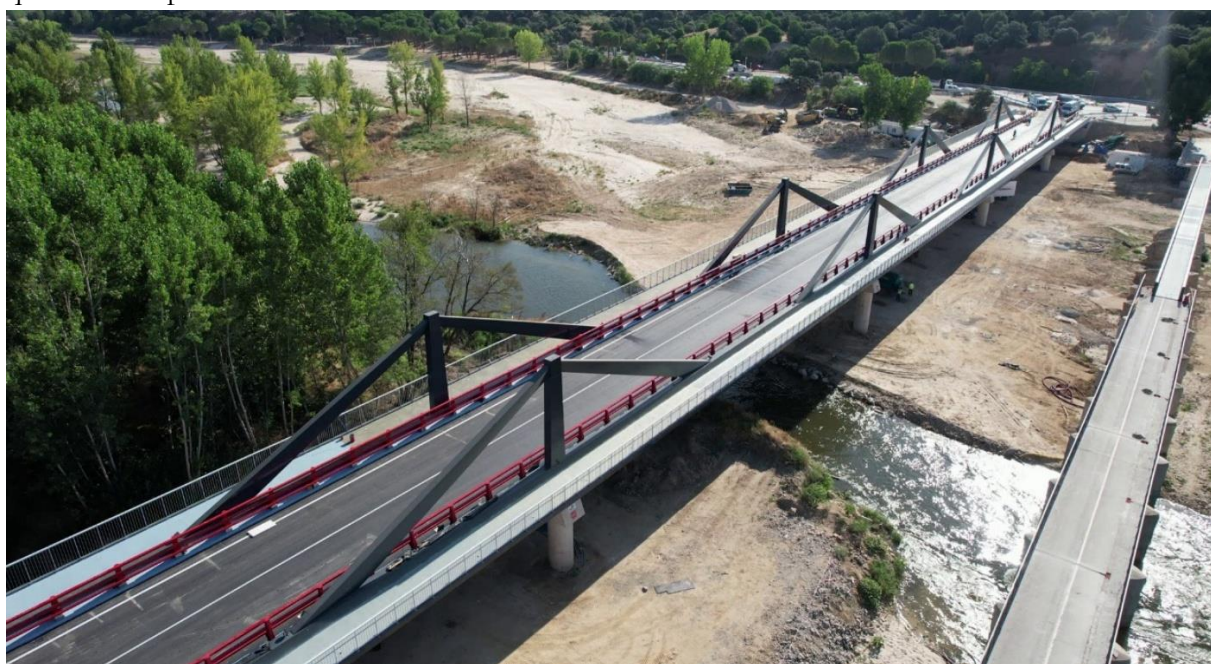
Figura 4. Vista aérea del nuevo puente de La Pedrera.
