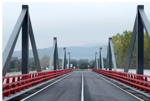
Figura 3. Vista interior a través del nuevo puente.
