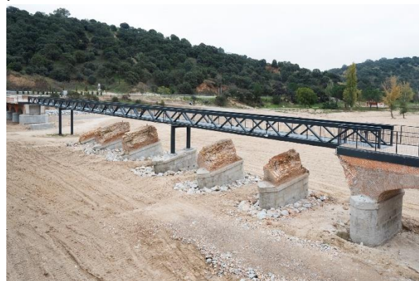
Figura 7. Nueva pasarela peatonal sobre el antiguo puente de La Pedrera.
