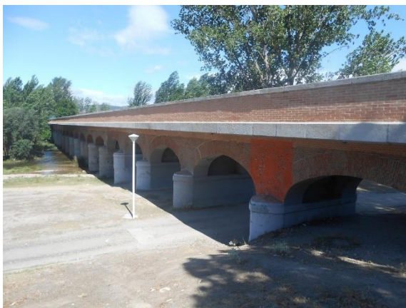
Figura 6. Puente original de La Pedrera (s. XVIII)
