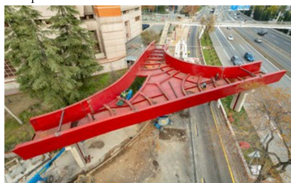
Figura 9. Montaje de la plaza en su posición final.
