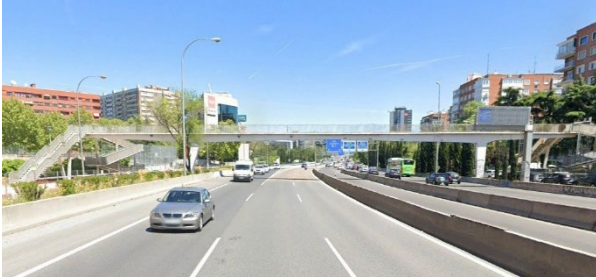
Figura 1. Pasarela original sobre la A-2.
