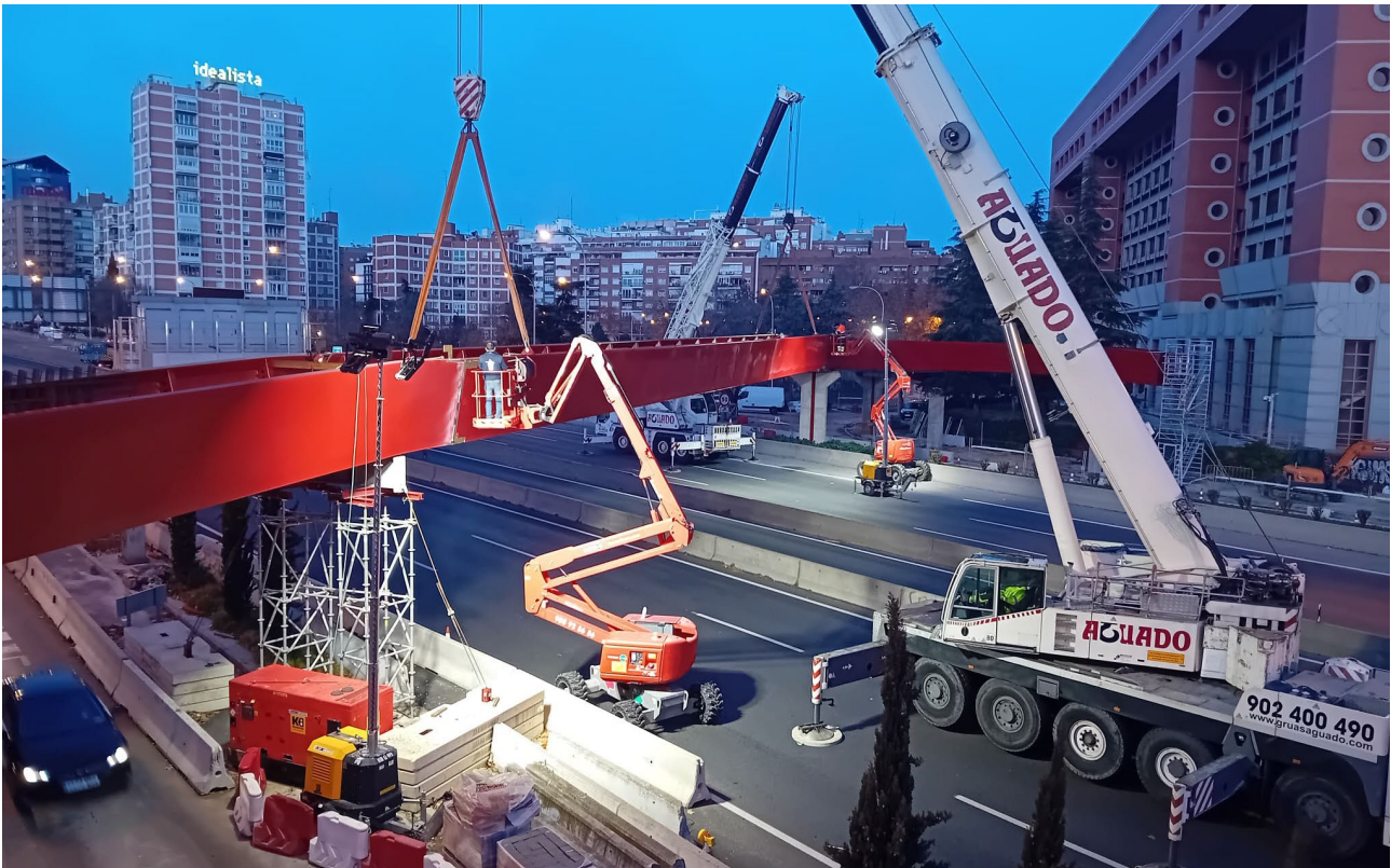
Figura 10. Montaje del tramo central de la pasarela peatonal sobre la A-2.
