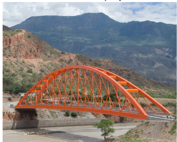
Figura 5. Puente con péndolas susceptibles de VIV (Puente de Antonio Raimondi, Perú)
