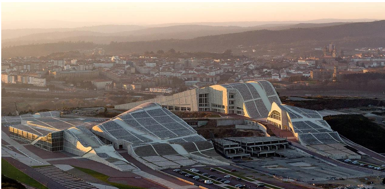
Figura 3. Vista general estructura aparcamientos inacabada.
