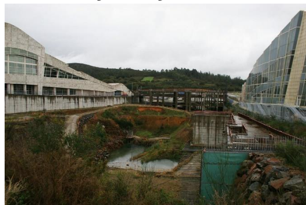
Figura 2. Estado previo estructura aparcamientos.
