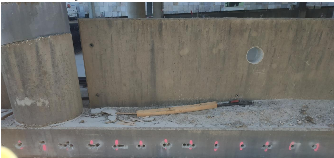
Figura 11. Vista de taladros ejecutados en canto de forjado.
