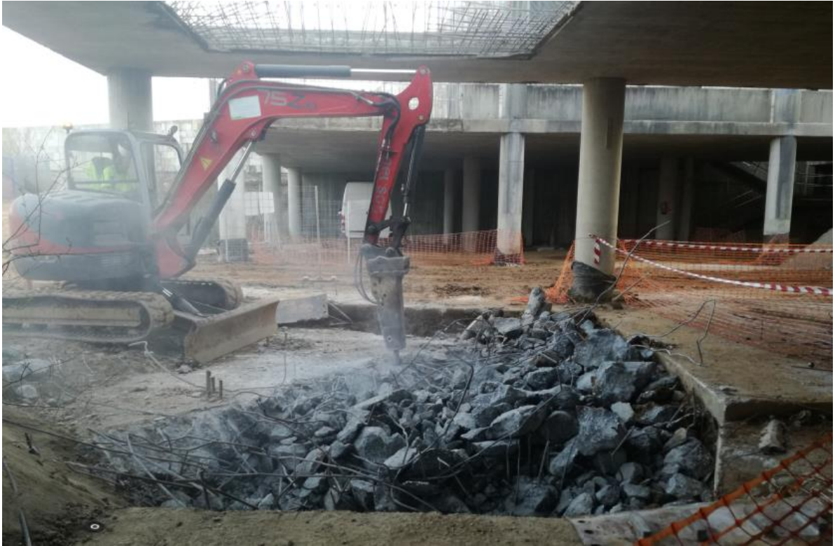
Figura 12. Vista de maquinaria de demolición bajo forjado existente.
