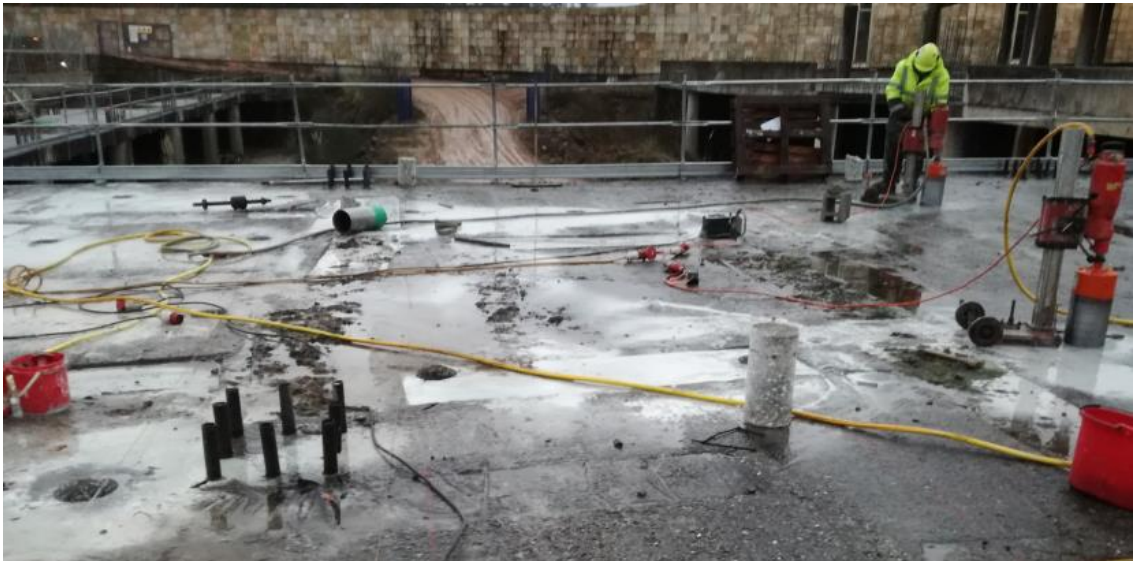
Figura 10. Vista de taladros ejecutados en losas.
