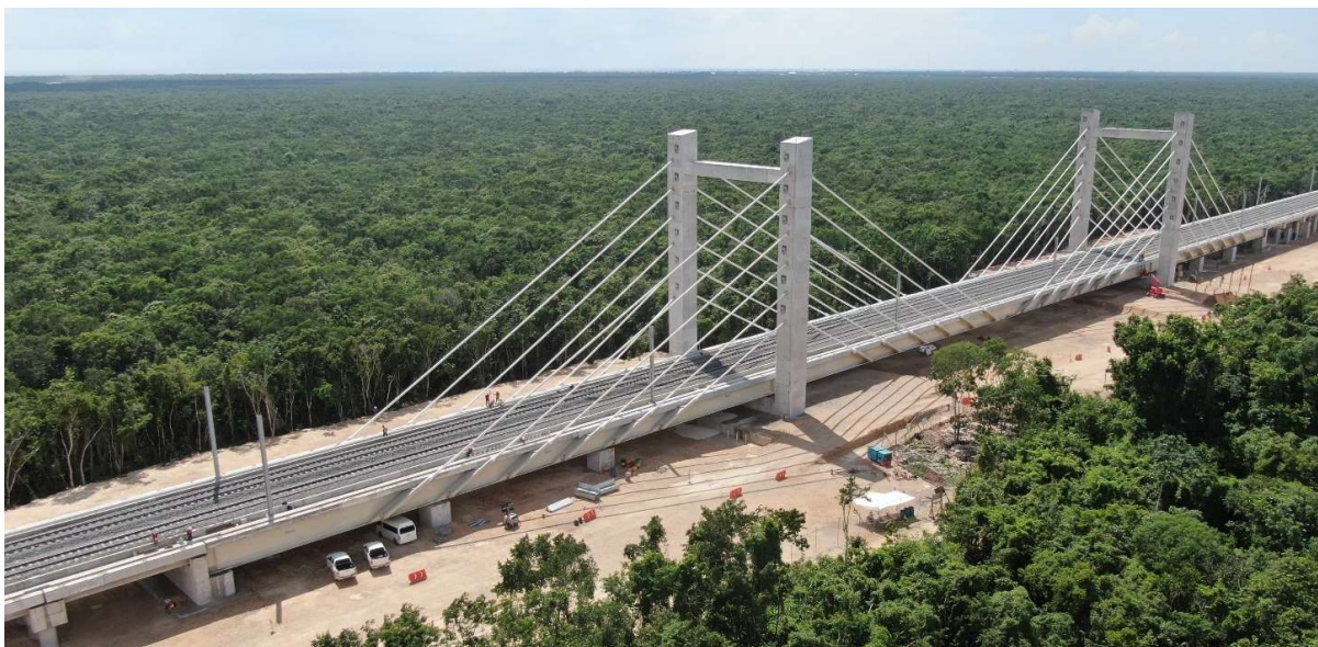
Figura 3. Viaducto Garra de Jaguar.
