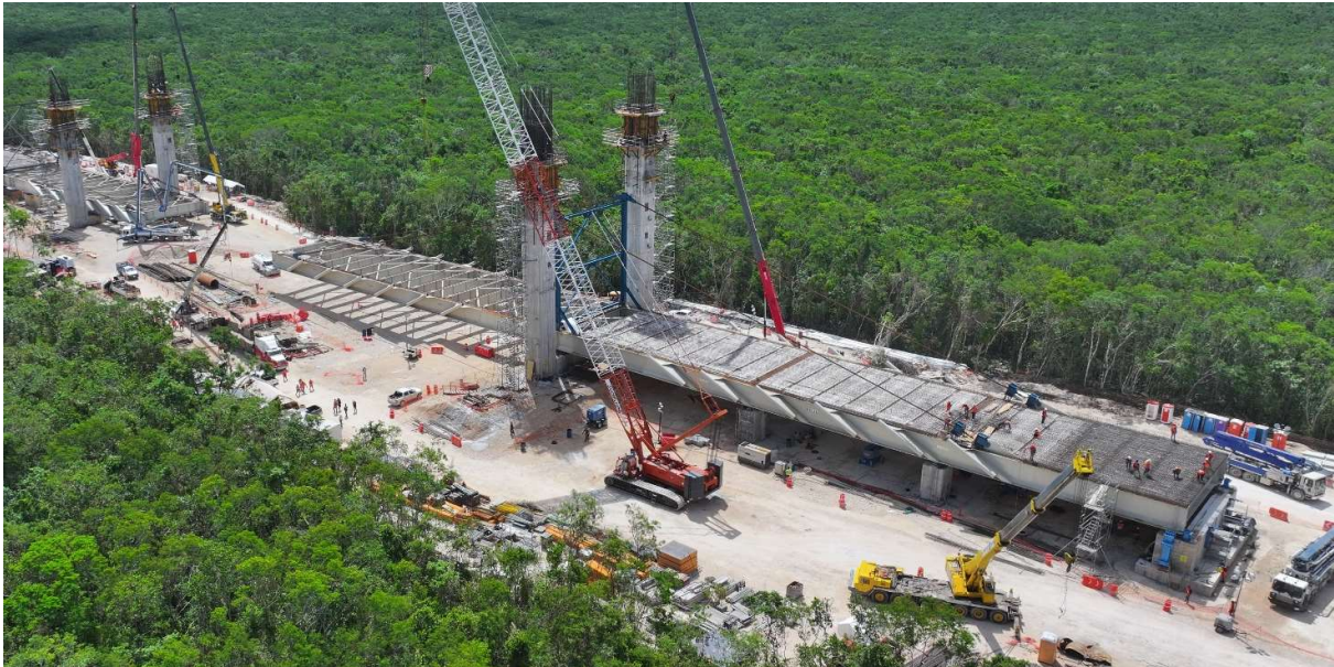
Figura 14. Empuje completado en uno de los tableros.
