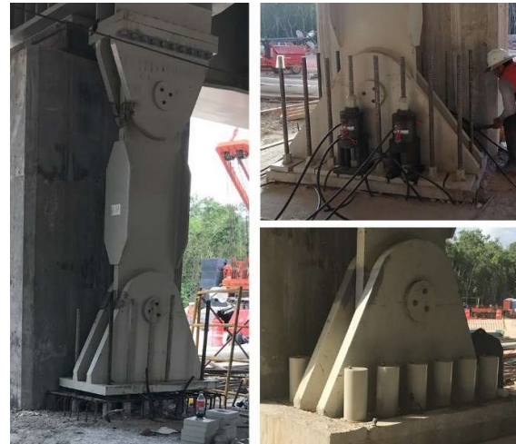
Figura 8. Biela de anclaje en pilas de retenida.
