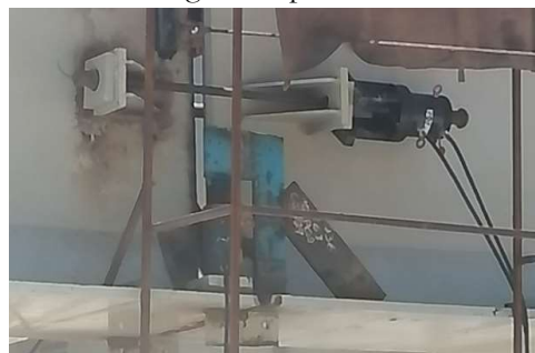
Figura 19. Acercamiento y cierre entre tableros.
