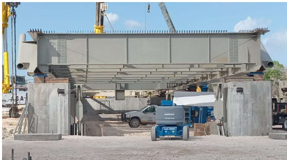
Figura 5. Vista de las vigas transversales y longitudinales.
