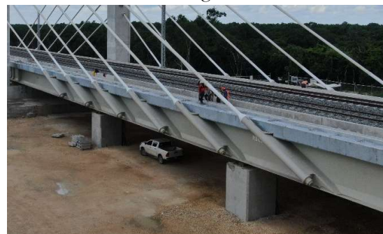
Figura 6. Vista de anclajes de tirantes en tablero.
