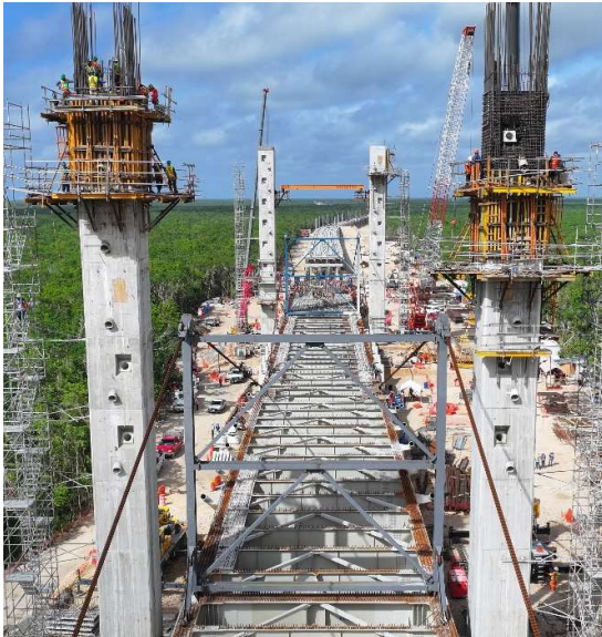
Figura 10. Ejecución de fustes de pilonos.
