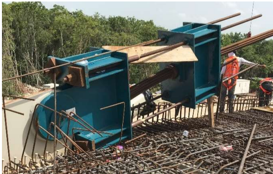
Figura 15. Anclaje activo de atirantamiento provisional.
