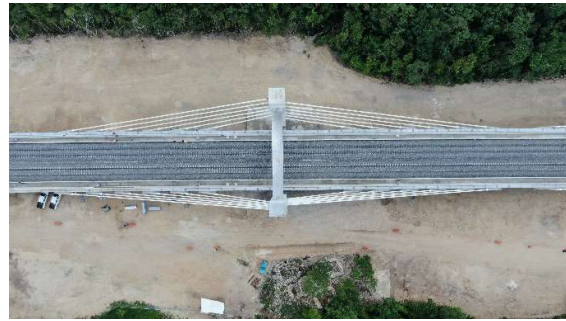
Figura 11. Vista en planta de pilonos.
