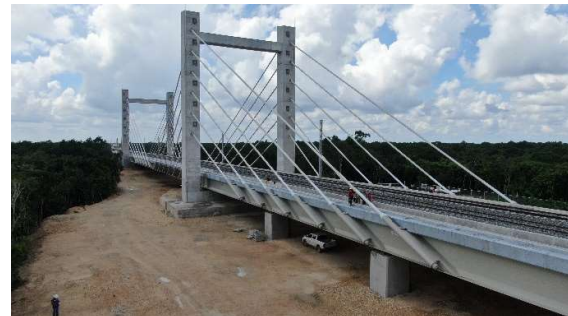
Figura 9. Vista general de pilonos.
