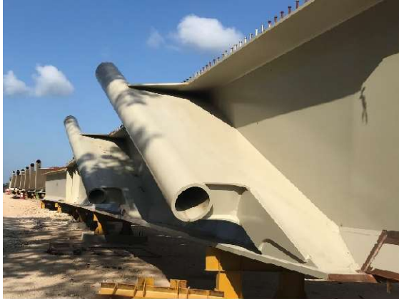
Figura 7 Detalle del anclaje de tirante en tablero.
