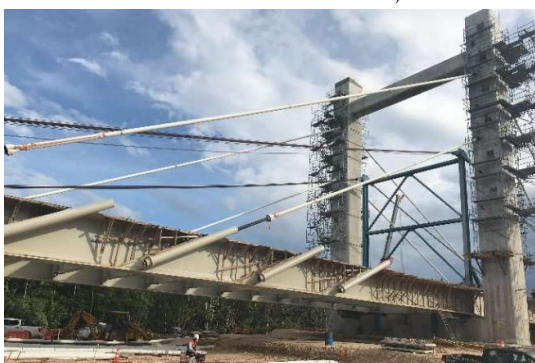
Figura 17. Instalación de primeros tirantes.
