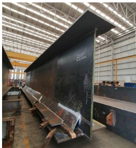
Figura 4. Viga longitudinal en fabricación.
