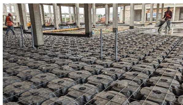
Figura 3. Ejecución de forjado sanitario con casetones plásticos
