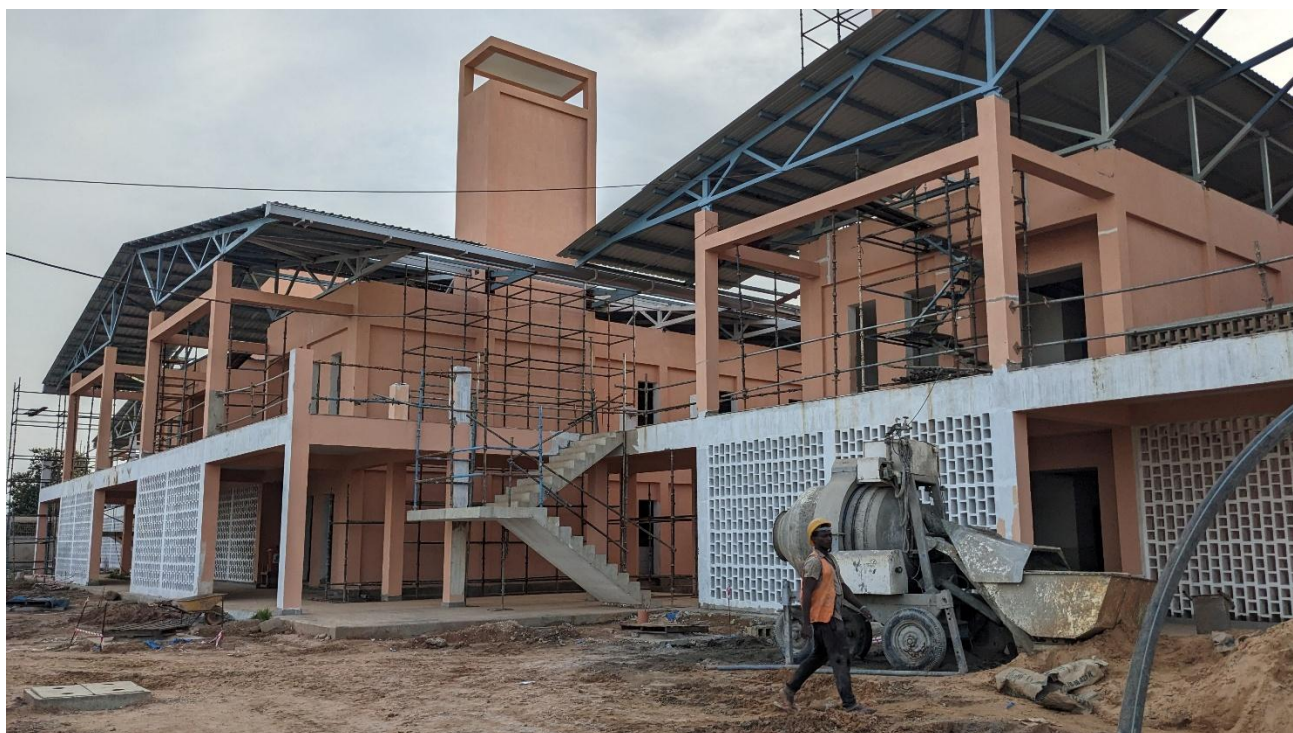
Figura 10. Estado actual de la obra del hospital
