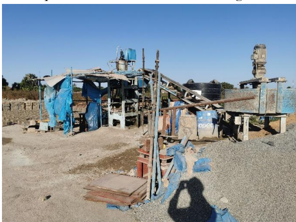
Figura 9. Instalación de fabricación de bloques de hormigón en obra
