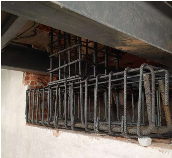
Figura 22. Zapata de apoyo de nuevo pilar.
