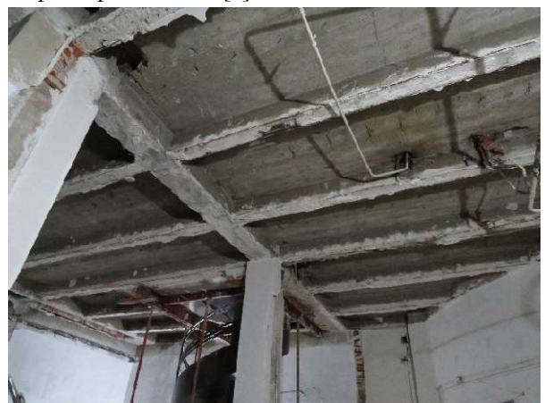
Figura 3. Vista de un forjado de hormigón del edificio Metrópolis.
