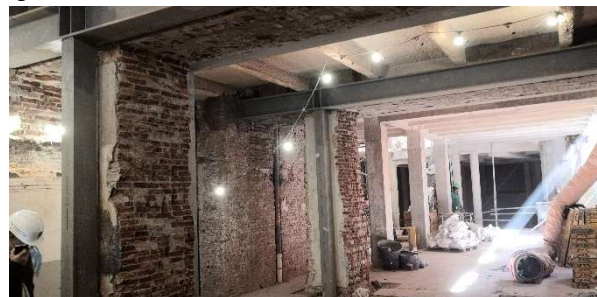
Figura 19. Vista del sótano con los dos muros ya apeados.
