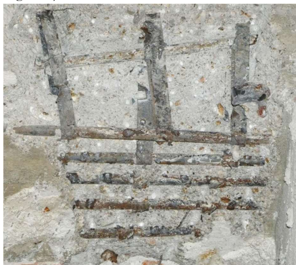
Figura 9. Disposición de la armadura longitudinal y flejes de cortante de una viga tras la realización de una cata.
