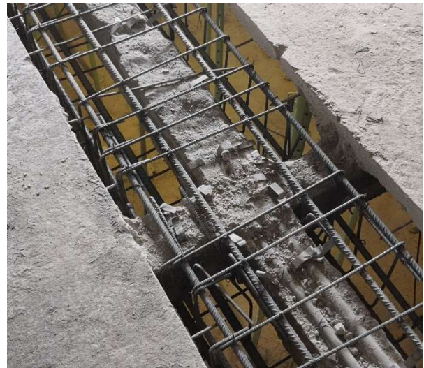
Figura 14. Detalle de armado de nervio.
