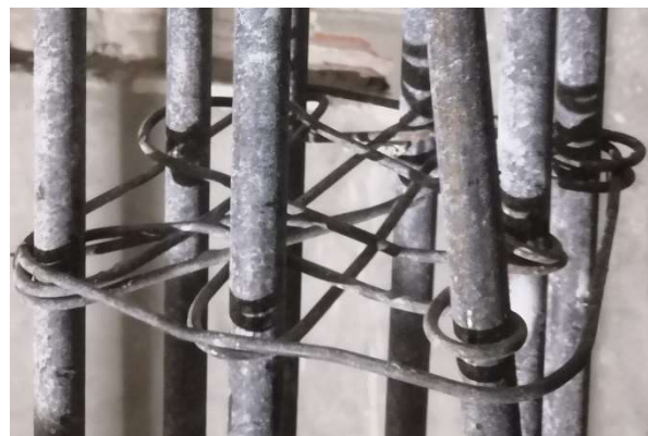
Figura 10. Disposición de la armadura de atado en un pilar tras su demolición.
