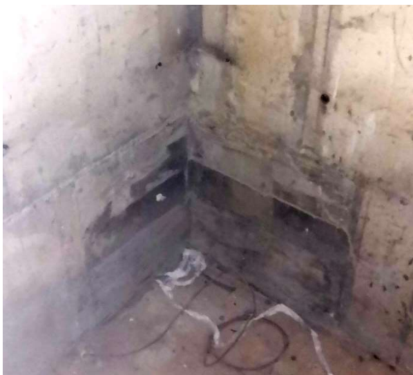
Figura 17. Segunda fase de hormigonado del espacio dejado para la zapata del pilar.
