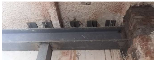
Figura 18. Ejecución de pasadores para apeo de muro de fábrica.
