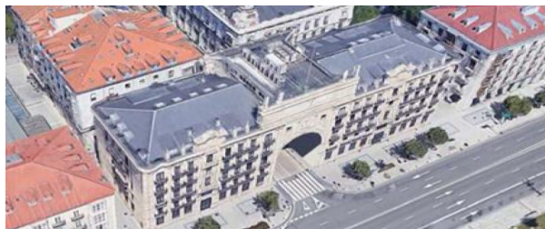
Figura 2. Vista general del edificio en su estado inicial. Fachada Sur
