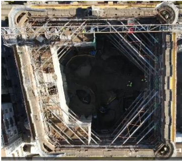
Figura 7. Esquema de la estabilización interior ejecutada
