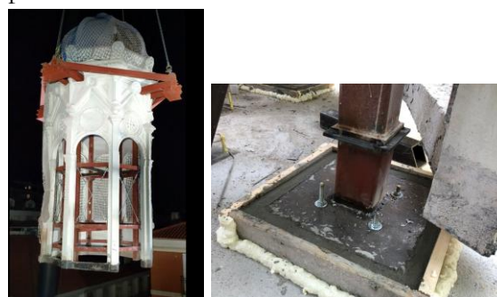
Figura 21. Vista general del izado de uno de los cenadores y detalle de apeo del cenador en el endoesqueleto durante su apoyo en planta baja.
