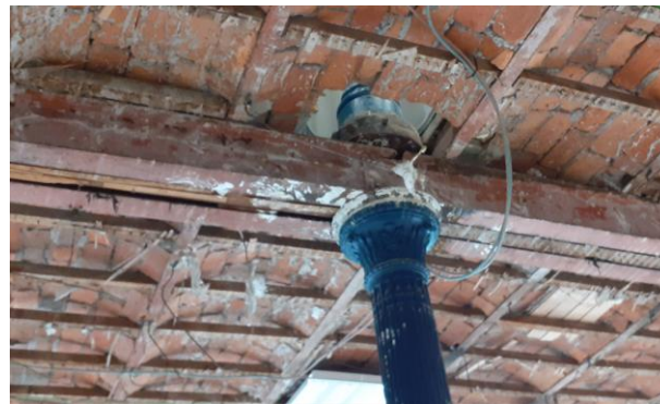
Figura 2. Transición de pilares de fundición.
