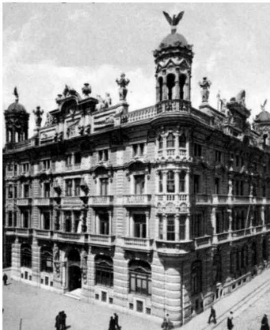
Figura 1. Vista general del edificio original.
