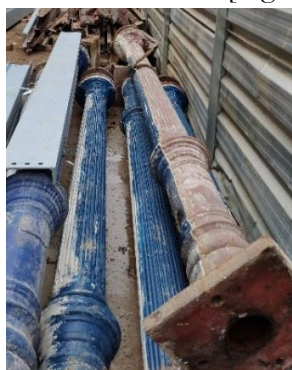
Figura 15. Vista general de pilares de fundición.
