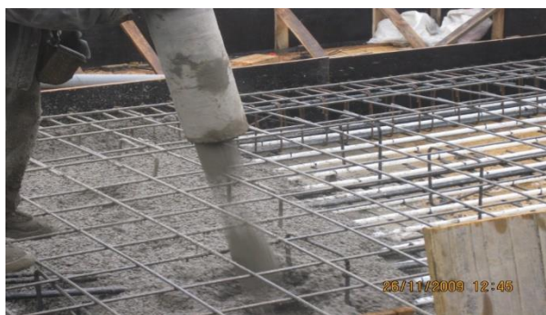
Figura 5. Hormigonado de un forjado con TABS en la sede de IDOM en Madrid
