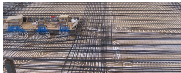
Figura 4. Foto de un forjado (sede IDOM Madrid) en proceso de construcción antes de la colocación de la armadura superior del mismo y previa a su hormigonado. Las vainas negras son para el postesado de la estructura. Las tuberías de TABS son de color blanco.
