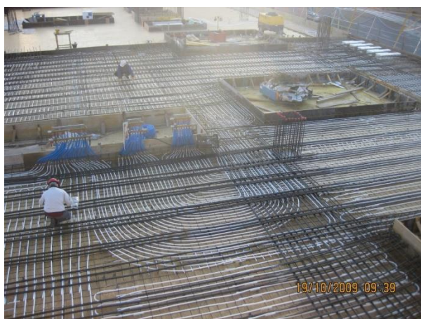
Figura 2. Foto de obra de la sede de IDOM en Madrid con estructura activa
