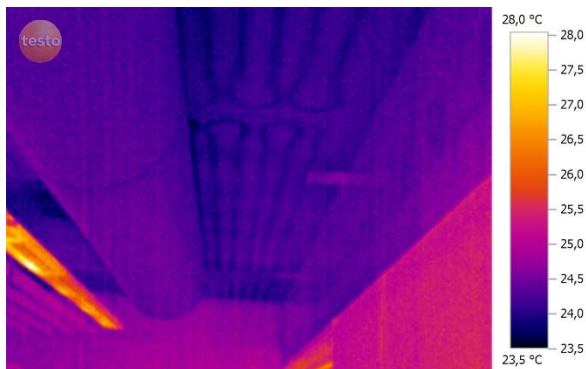
Figura 12. Termografía de un techo de la sede de IDOM en Madrid con los TABS en funcionamiento. Se observa que la temperatura mínima que alcanza la superficie es de 23,5°C
