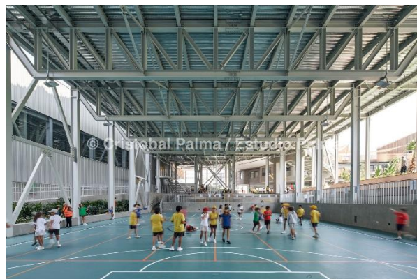
Figura 16 Vista interior del Sport Core
