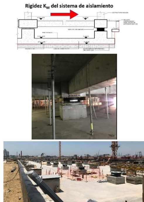
Figura 5. Sótano técnico para la colocación de aisladores sísmicos.
