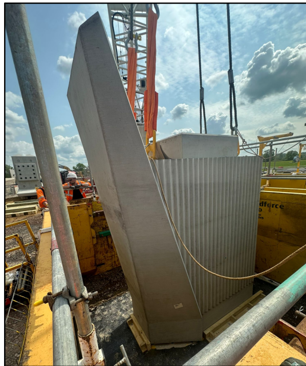
Fig. 11. Izado de pila prefabricada (TVV).
