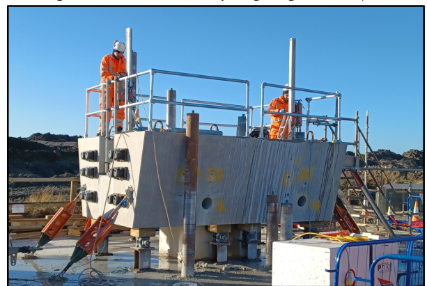
Fig. 8. Ensayo 1:1. Testigos de inyección (TVV).
