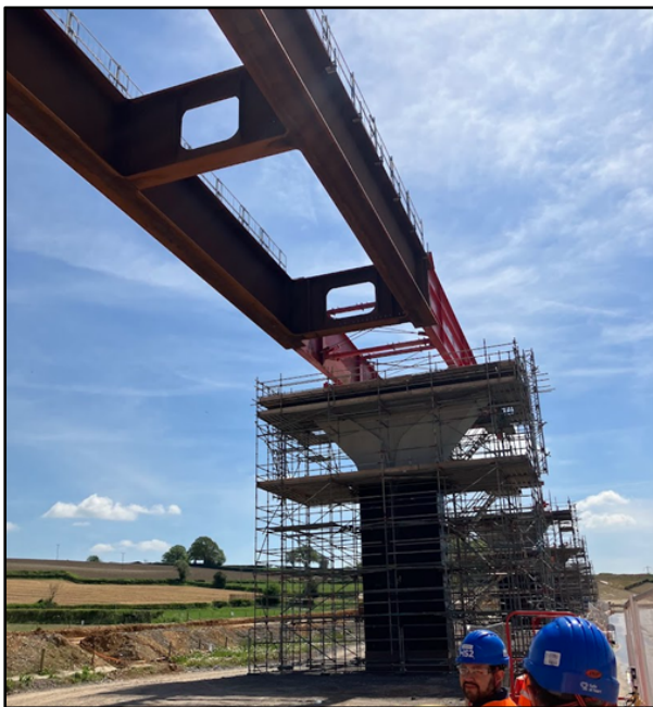
Figura 4. Empuje del tablero metálico (Wendover).
