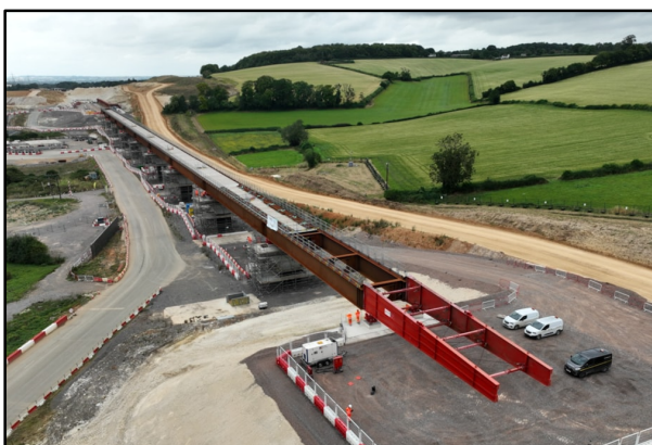
Figura 5. Empuje finalizado (Wendover).
