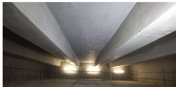
Figura 19. Estado final del forjado-tapa de cubierta
