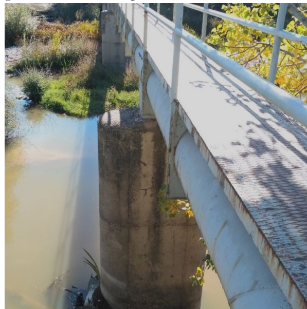
Figura 9. Pilas existentes de la tubería autoportante.
