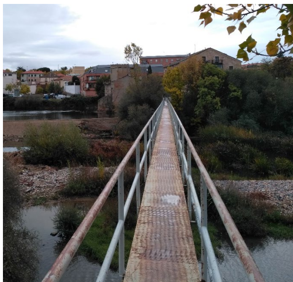
Figura 8. Pasarela existente sobre tubería autoportante.
