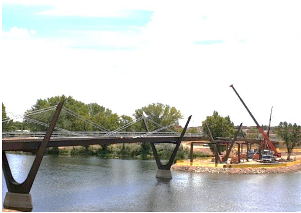
Figura 6. Montaje de la pasarela
