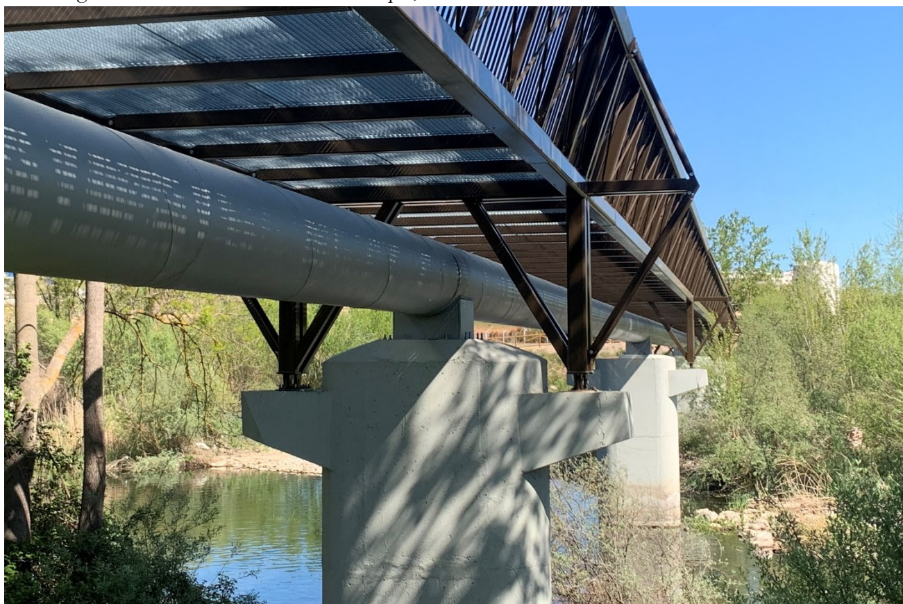
Figura 14. Arriostramiento lateral de los vanos y conexión con pilas.
