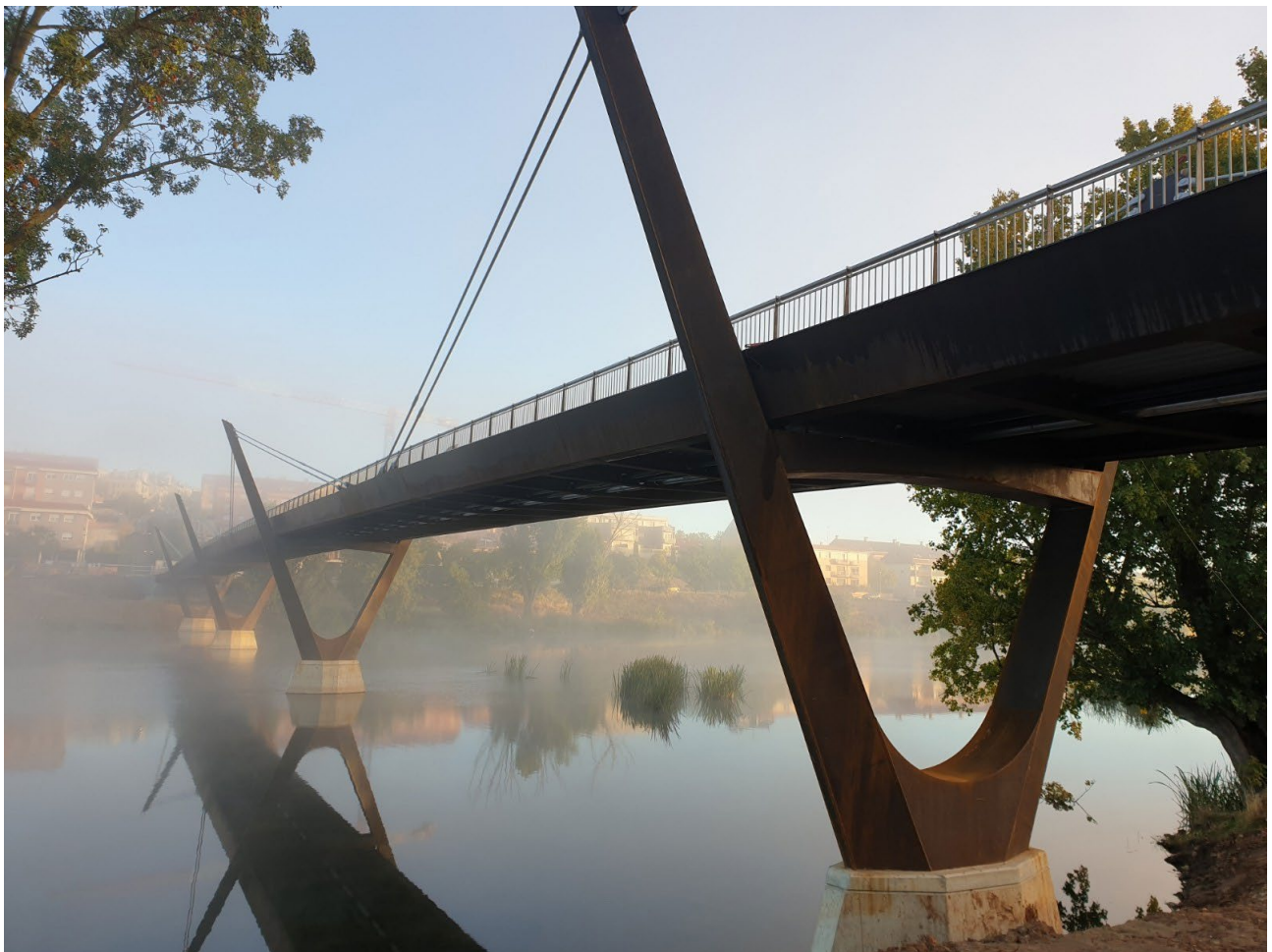
Figura 7. Vista de la pasarela desde el Barrio de Tejares
