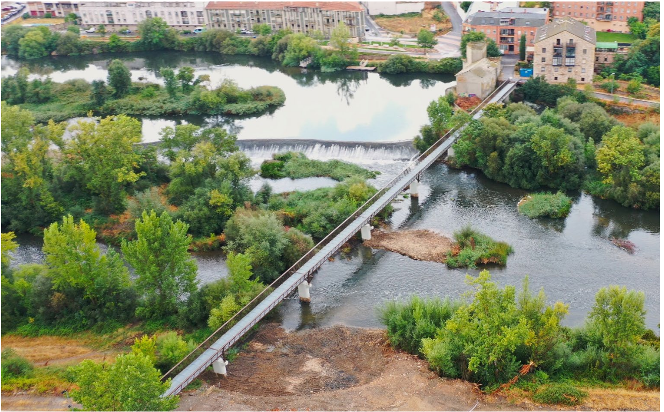
Figura 10. Vista aérea del nuevo tablero.
