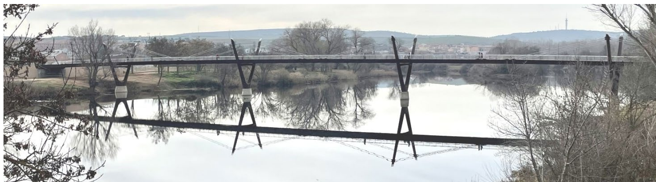
Figura 1. Vista general de la pasarela
