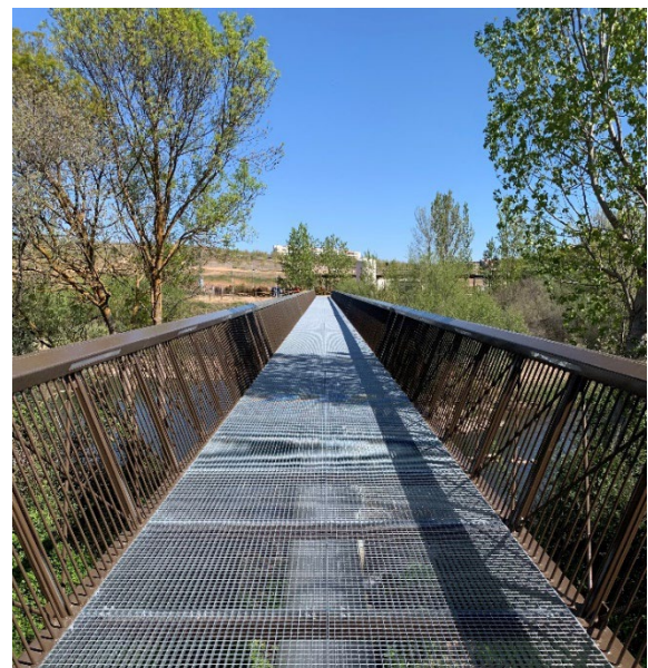
Figura 12. Vista interior de la pasarela
