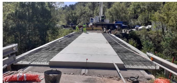
Figura 5. Prelosa con zona central macizada.
