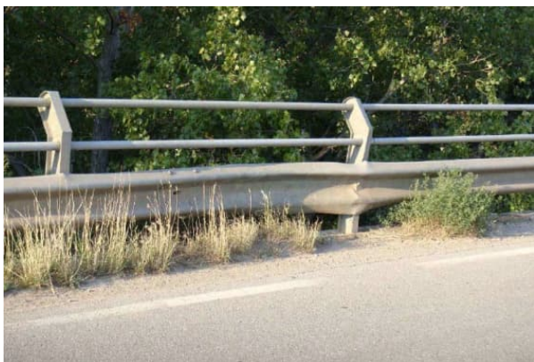
Figura 8. Barrera de contención existente.
