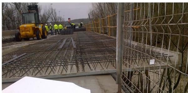
Figura 4. Vista superior de prelosa de celosía.
