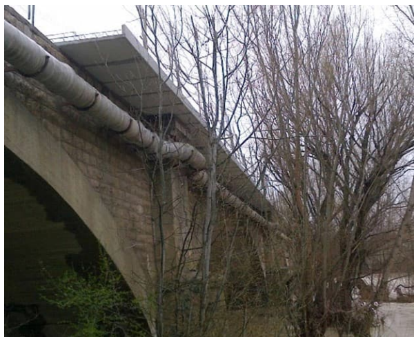
Figura 3. Vista inferior de nuevo voladizo.
