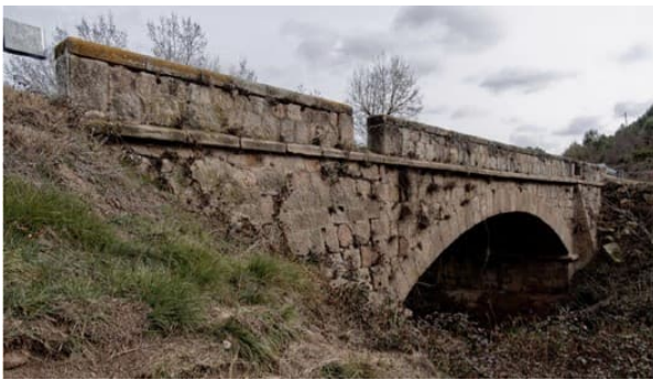
Figura 1. Puente de fábrica antes de intervención.
