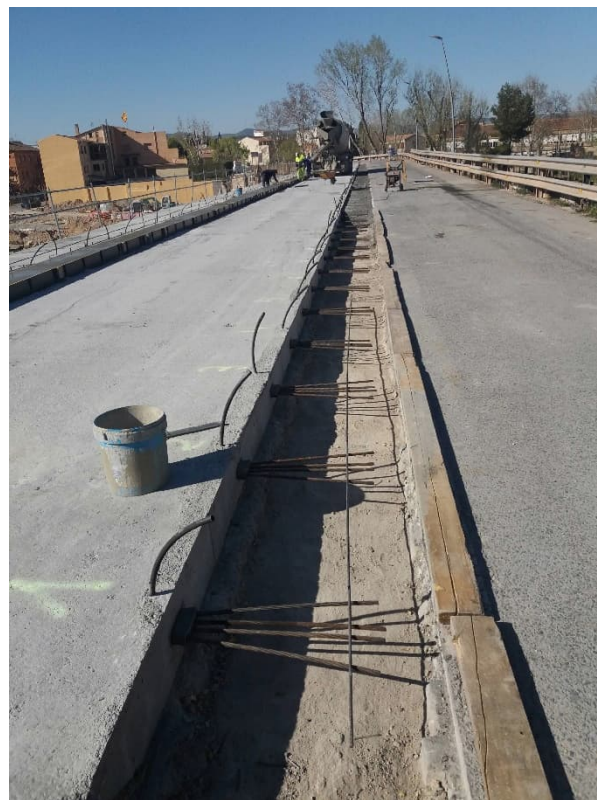
Figura 7. Ampliación de tablero con tendones de postesado.
