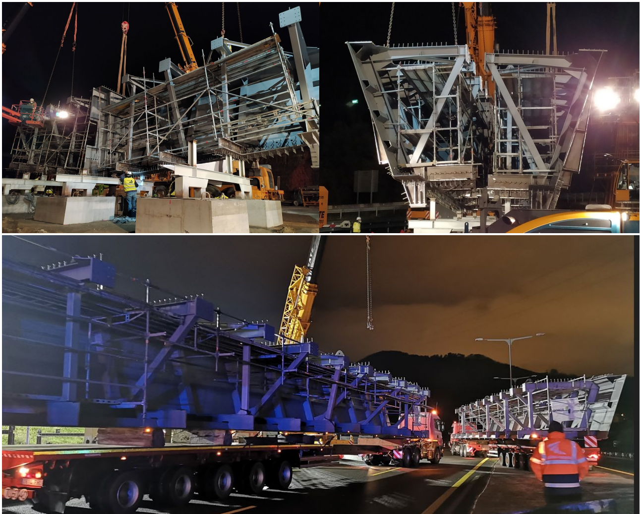
Figura 17. Ensamblaje en bancada de semitramos.
