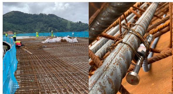
Figura 21. Ferrallado de losa y galgas
