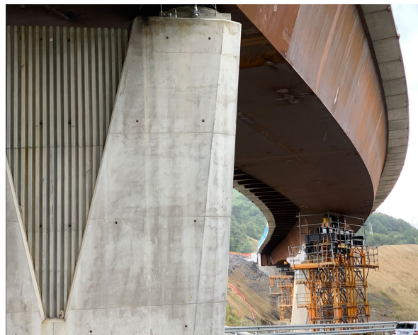
Figura 23. Vista inferior del tablero durante el desapeo monitorizando las reacciones
