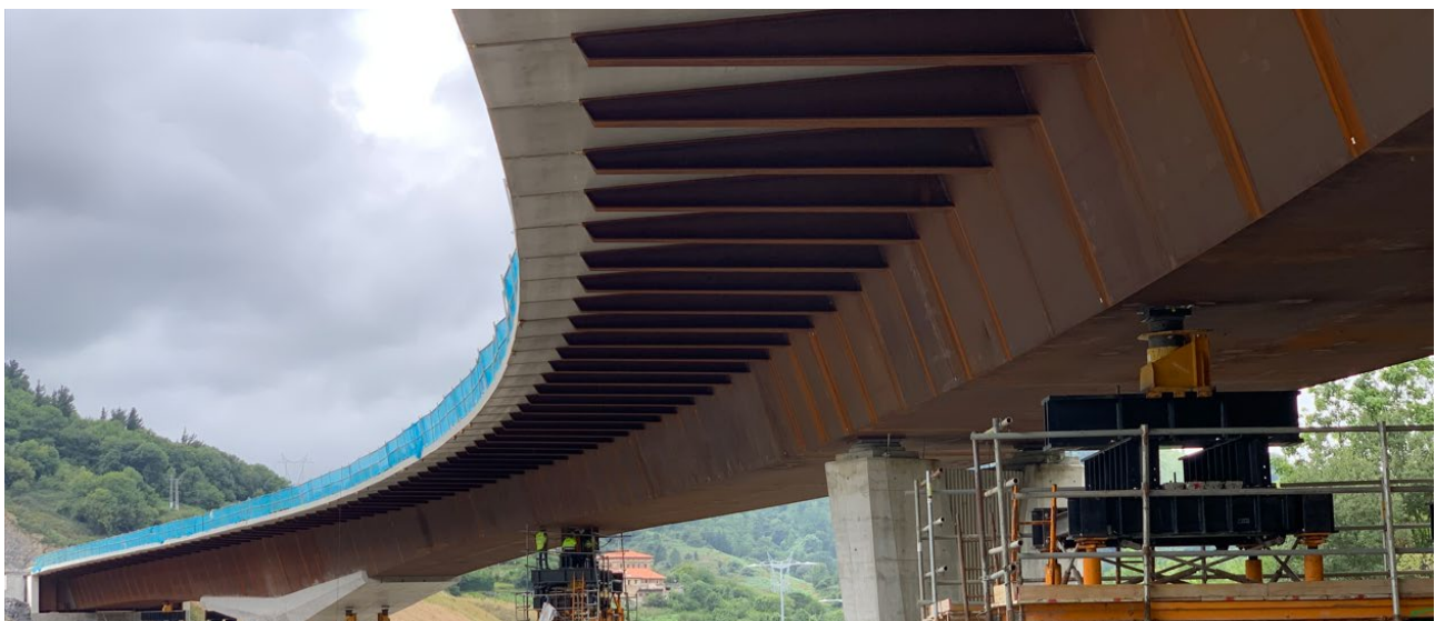
Figura 15. Costillas variables en vuelo Izquierdo.
