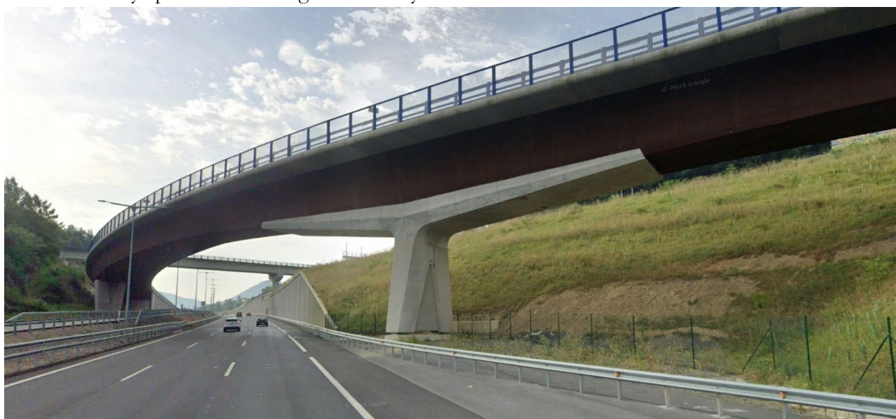
Figura 24. Vista de obra desde AP-68.
