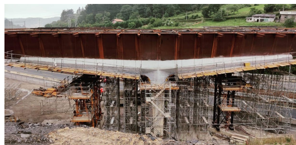
Figura 20. Comienzo desencofrado pajarita
