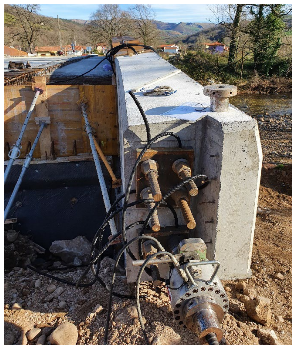
Figura 21. Tesado de barras de conexión.
