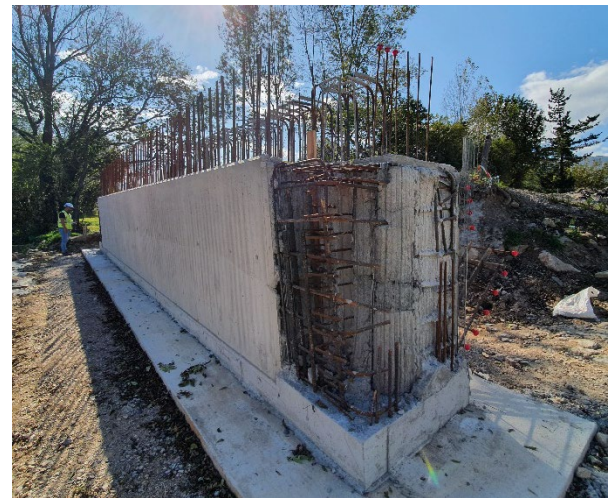
Figura 18. Alzado frontal de estribo.
