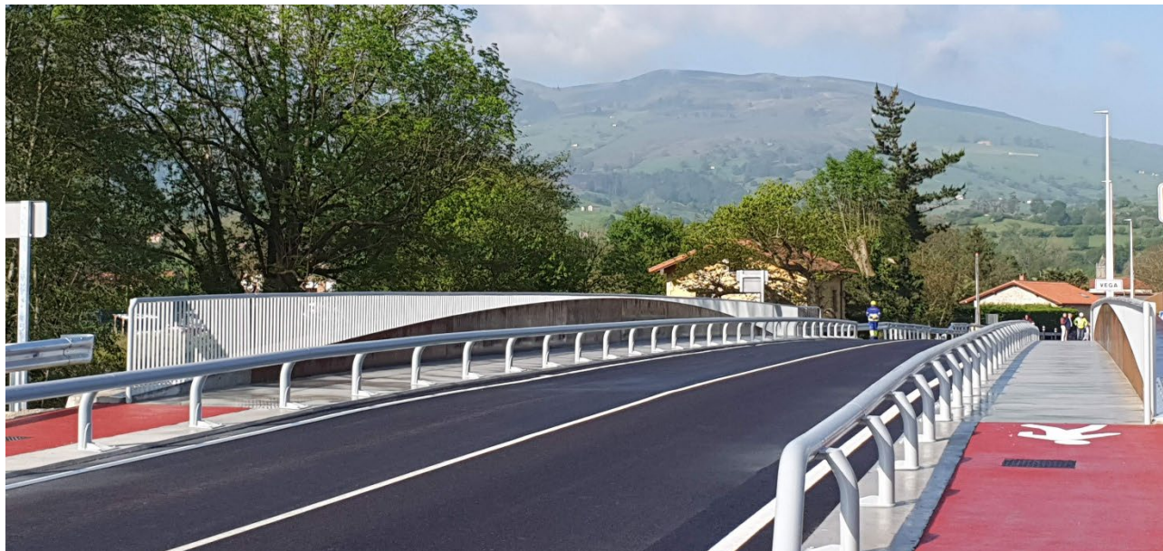
Figura 22. Vista del interior del puente tras su inauguración.
