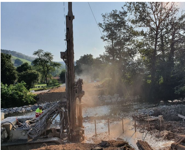
Figura 17. Ejecución de micropilotes.
