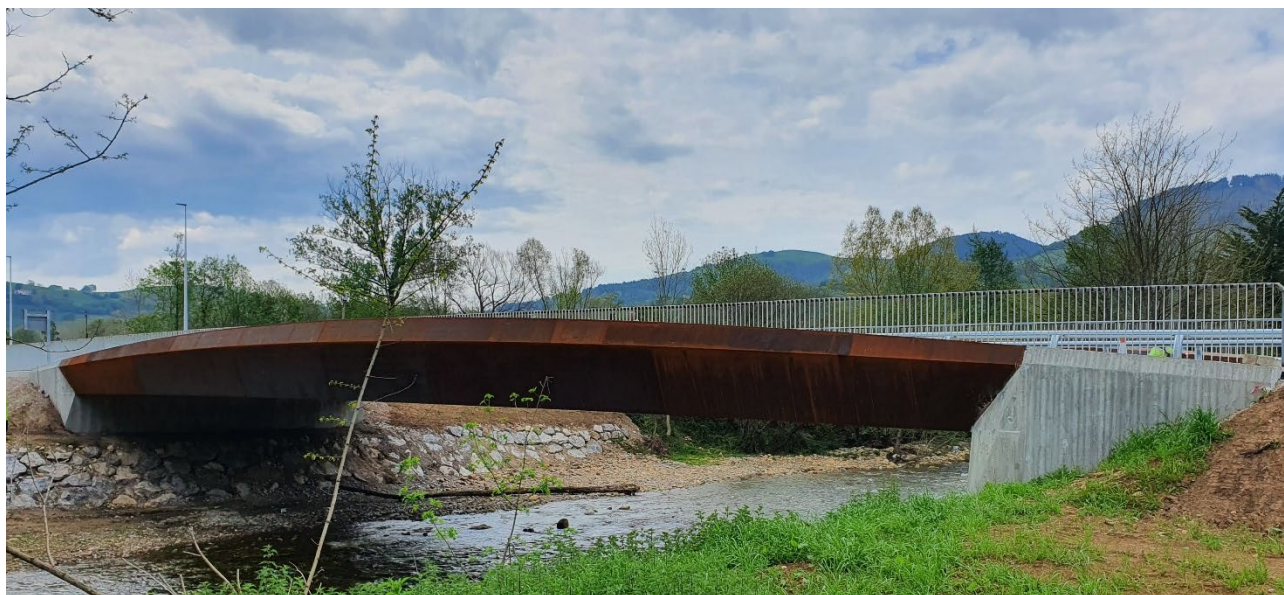
Figura 23. Vista del puente finalizado.
