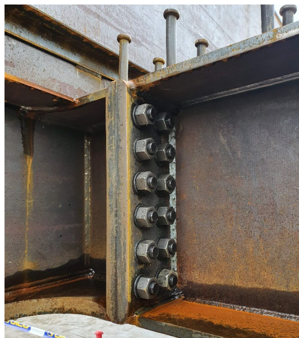
Figura 13. Detalle de unión atornillada.
