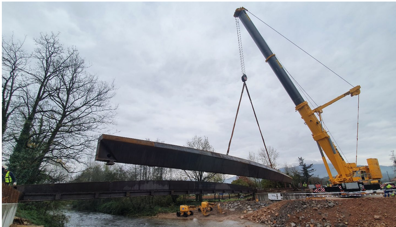
Figura 20. Posicionamiento de vigas longitudinales mediante grúa.
