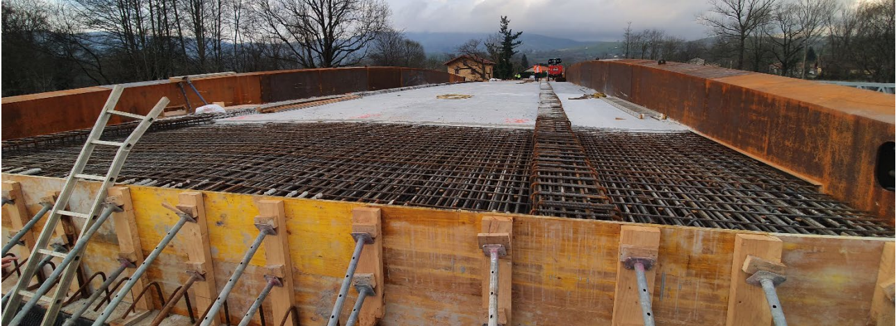
Figura 15. Losa de hormigón, a falta de hormigonar los extremos en conexión con el estribo.
