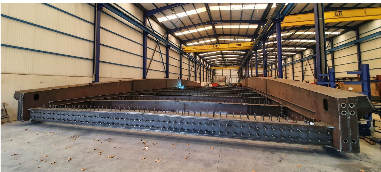
Figura 19. Montaje en blanco de la estructura metálica en taller.
