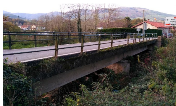
Figura 2. Puente existente sobre el cauce antiguo.
