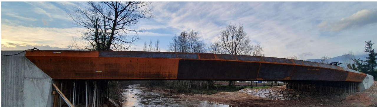
Figura 12. Nervio longitudinal del tablero con sección variable.
