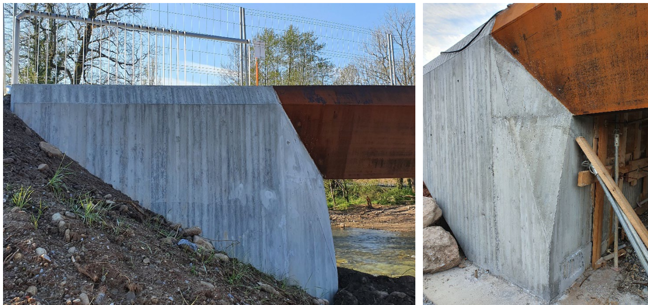
Figuras 9 y 10. Vistas de la aleta de estribo y su unión con el tablero.
