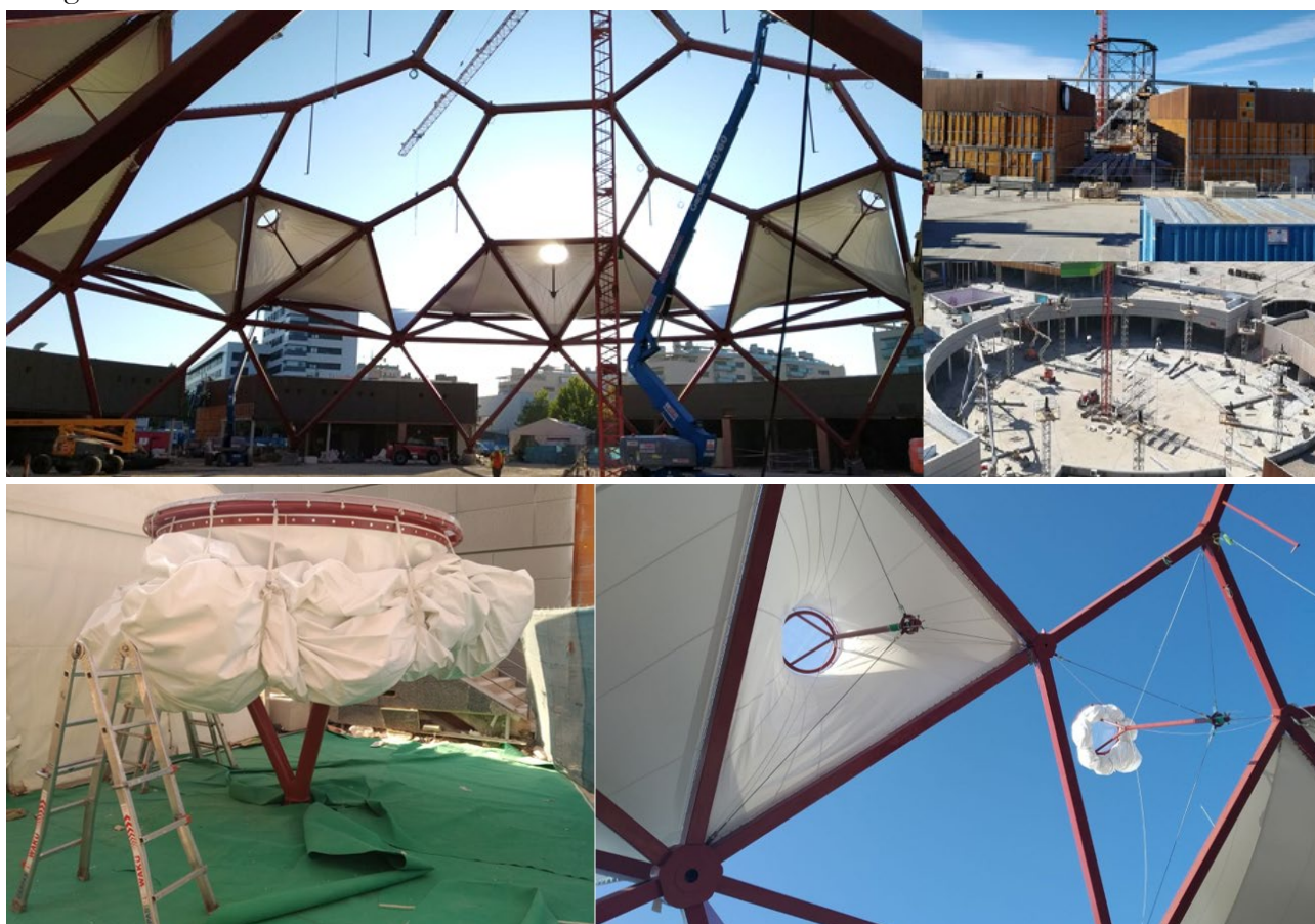
Figura 13. Distintas fases de ejecución de la cubierta.
