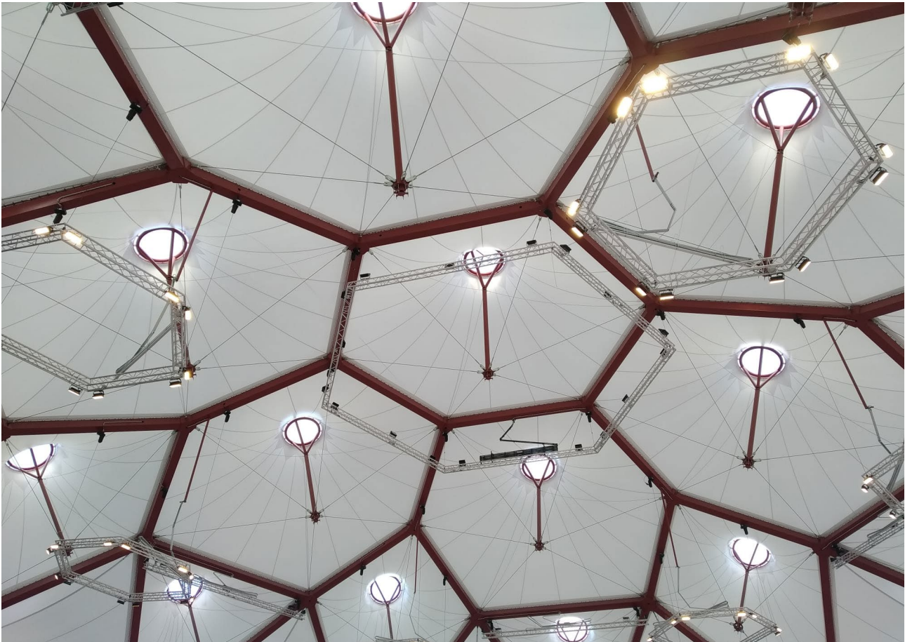
Figura 10. Vista desde interior de estructura metálica.
