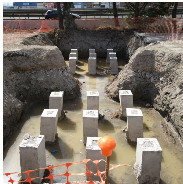
Figura 4. Pilotes hincados en encepado
