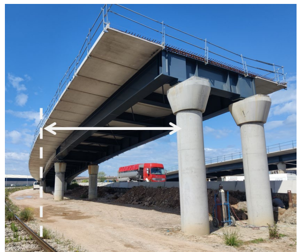
Figura 7. Pilas retranqueadas hacia el interior en el diafragma para salvar gálibo ferroviario
