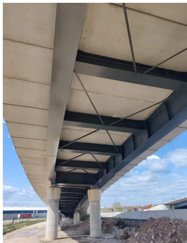
Figura 9. Vista inferior de viaducto de aproximación
