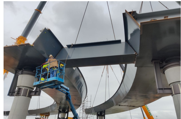
Figura 17. Viga transversal siendo instalada
