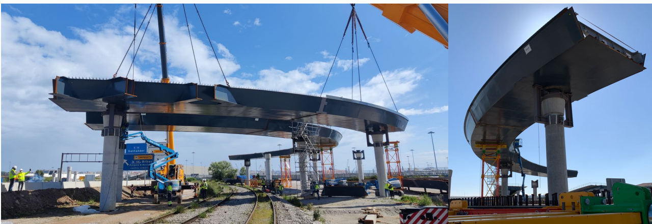
Figura 18. Montaje de tramos de dovela sobre ferrocarril. Se aprecian esperas para ramales de aproximación
