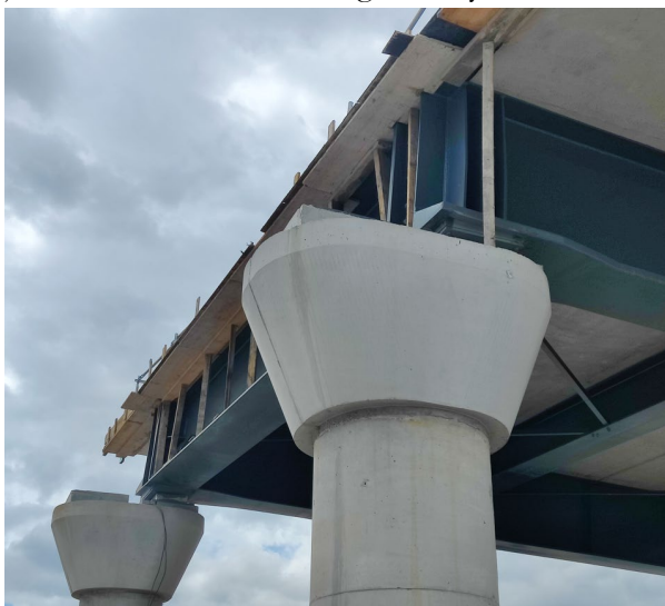
Figura 8. Capitel singular de fin de viaducto de acceso esperando apoyo de ramal de glorieta
