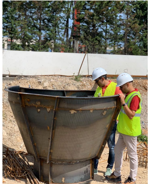
Figura 6. Encofrado de pila reutilizable
