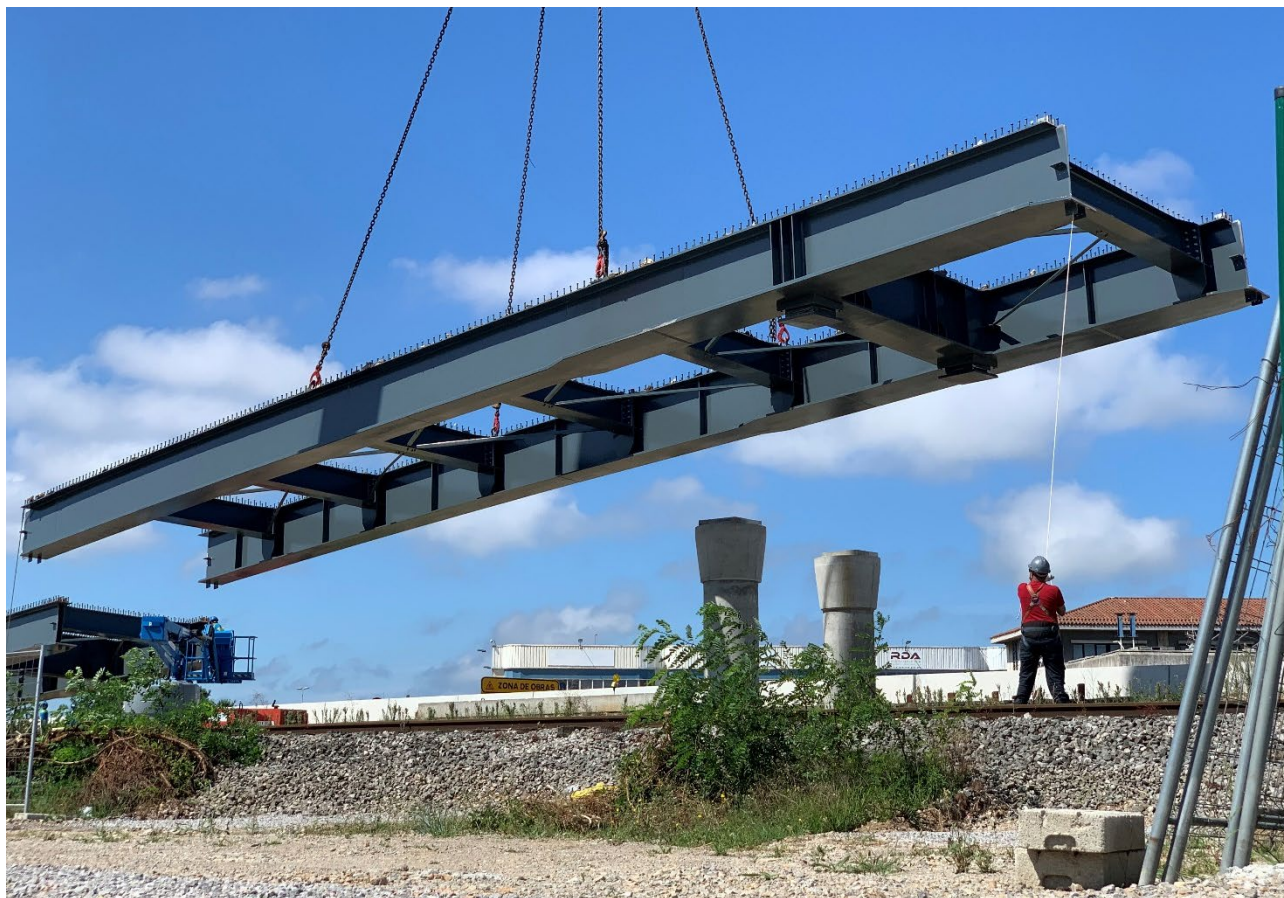
Figura 11. Tramo tipo metálico de viaducto de acceso izado
