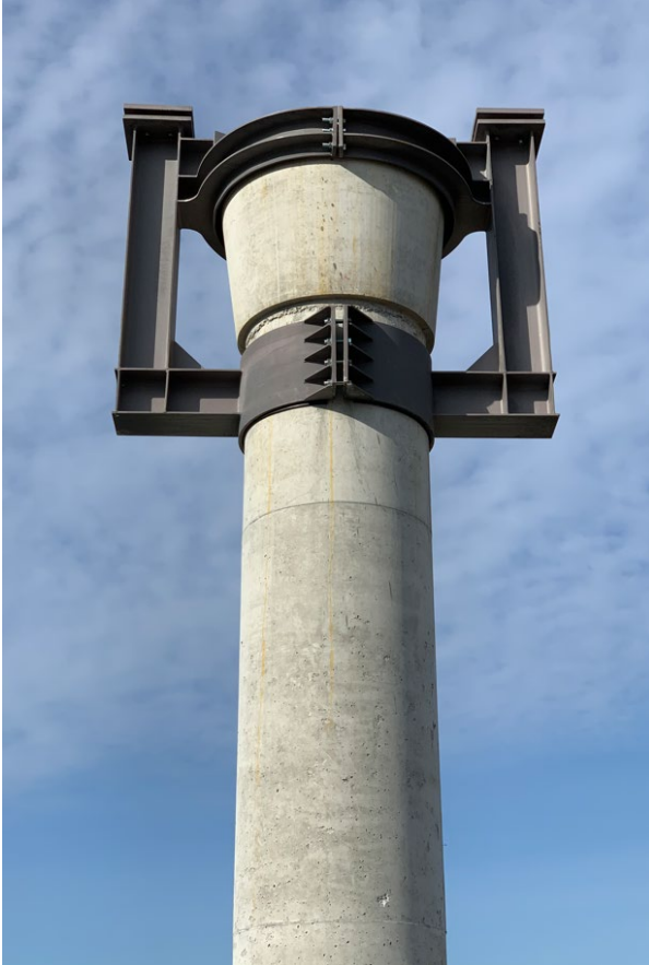
Figura 16. Pieza de control de giro en dovelas
