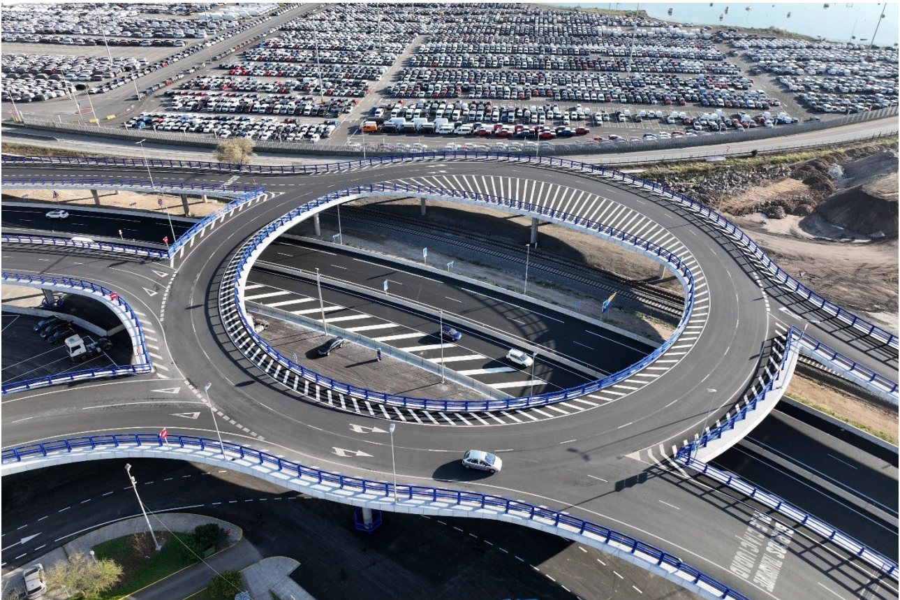
Figura 20. Enlace terminado y puesto en servicio
