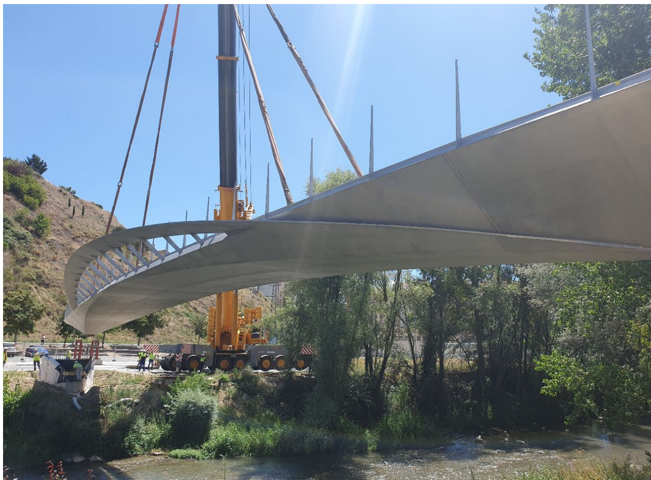
Figura 17. Secuencia de izado y posicionamiento final mediante grúa de gran tonelaje.
