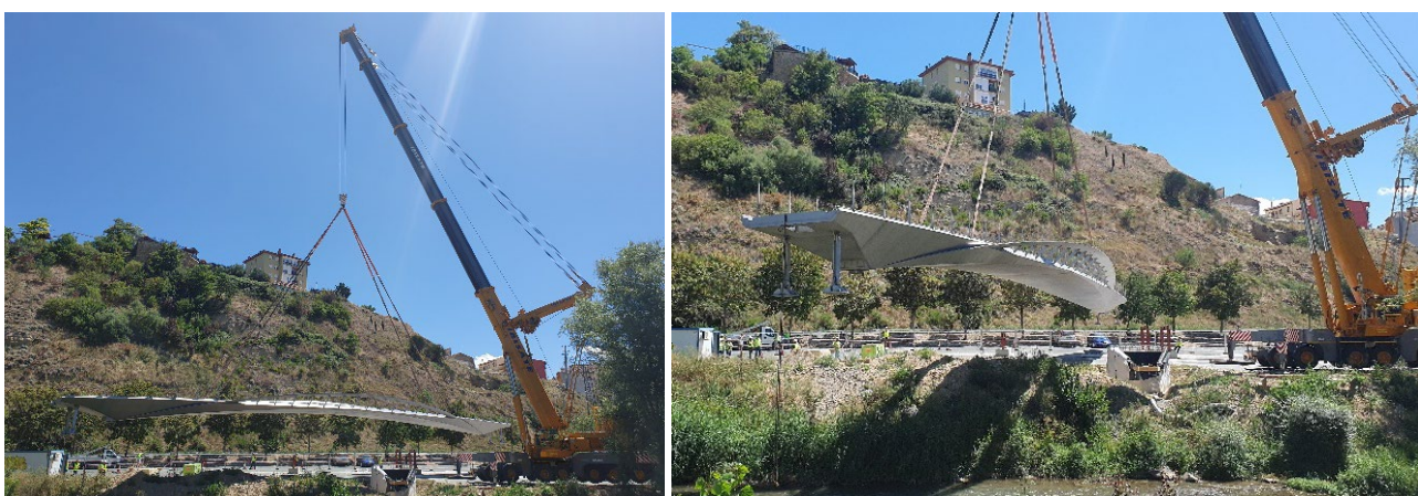
Figura 16. Secuencia de izado y posicionamiento final mediante grúa de gran tonelaje.
