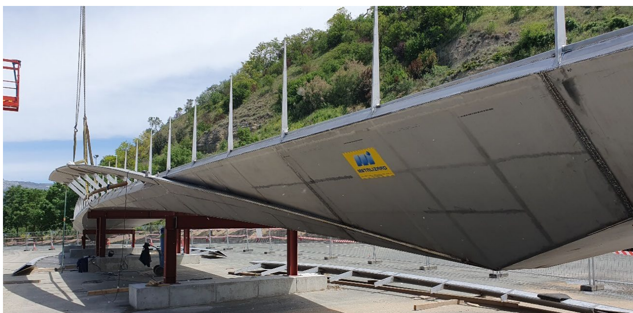
Figura 14. Ensamblaje de estructura metálica en obra.
