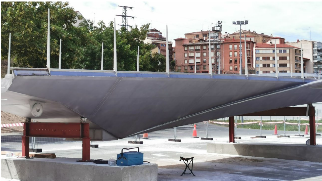
Figura 15. Detalle de zona tratada mediante granallado con esferas de vidrio.
