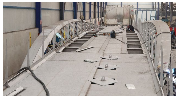
Figura 13. Fabricación de la estructura metálica en taller.
