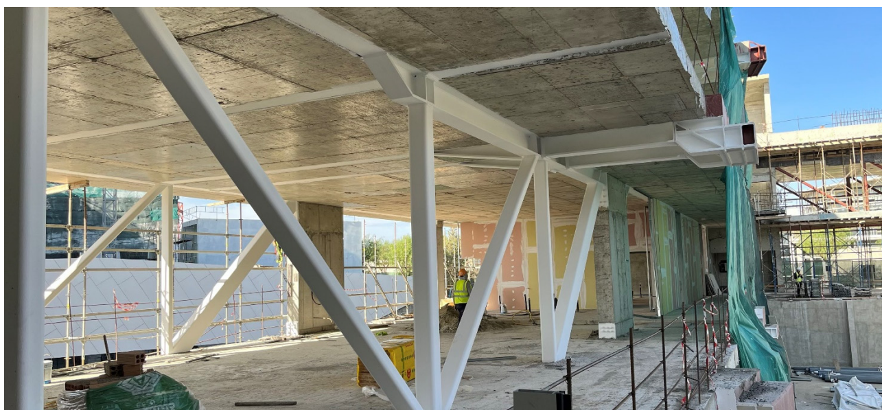
Figura 23. Vista desde el atrio de la estructura completa.
