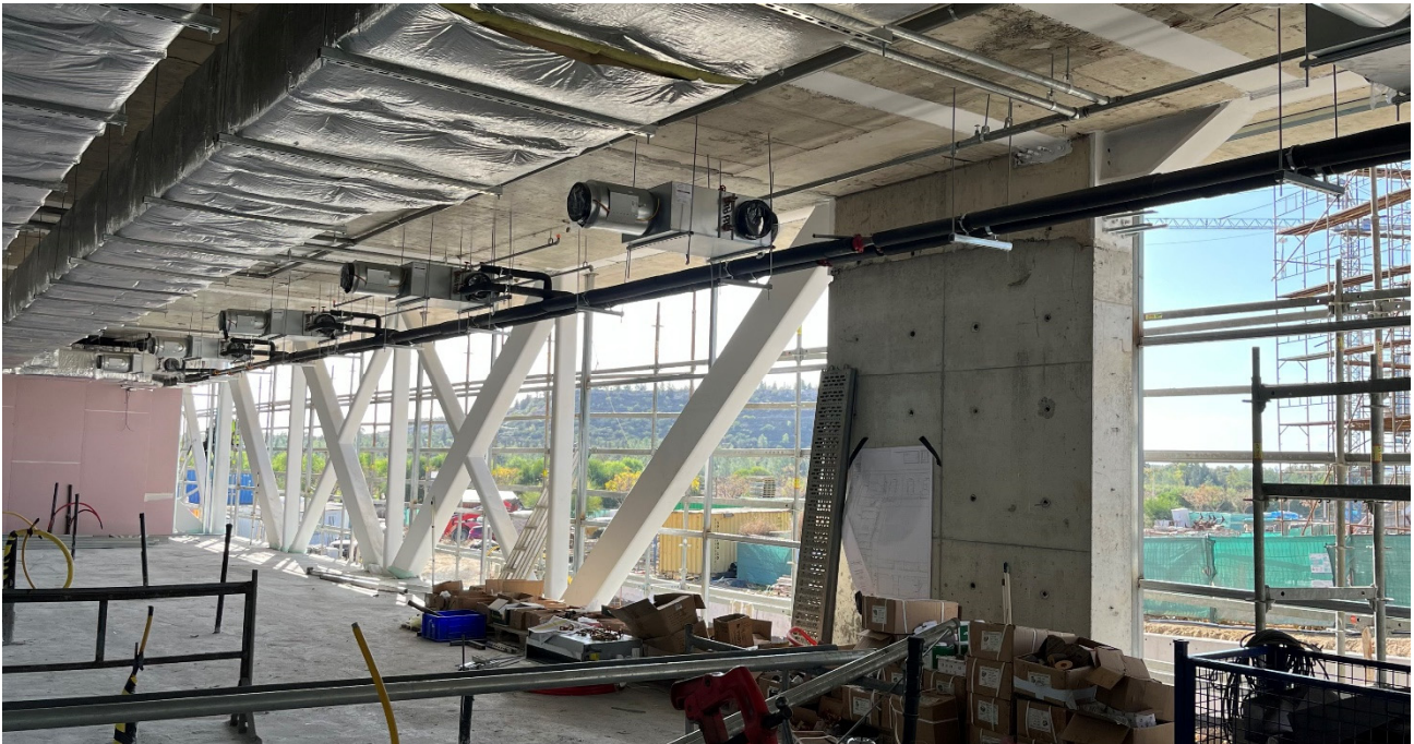
Figura 21. Vista desde el interior de la estructura completa.
