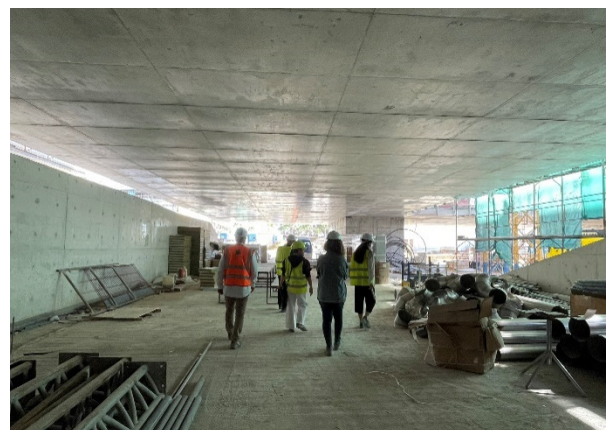
Figura 14. Vista del edificio desde abajo. El BT más el DOT suman 40m libres sin un pilar en la esquina
