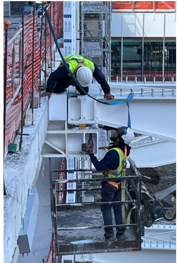
Figura 20. Izado y colocación de pasarelas y conexión de Pots Fijo en un extremo y Deslizante longitudinal en el opuesto.
