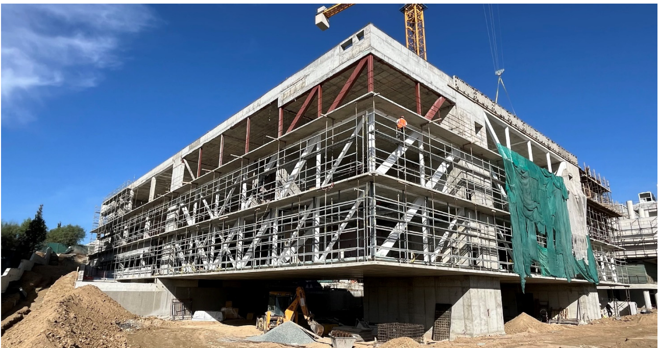
Figura 22. Vista desde el exterior del estructura completa.
