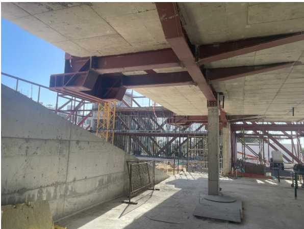
Figura 15. Subestructura de soporte de pasarelas.
