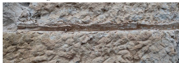
Figura 7. Junta de mortero original marcada con un pase de la punta de la paleta
