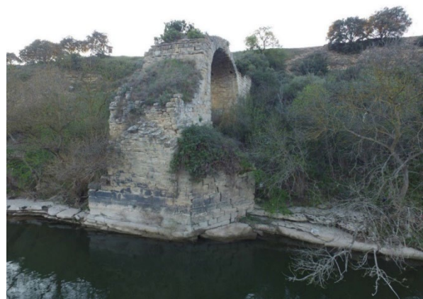
Figura 6. Estratos de cimentación lajados bajo pila.
