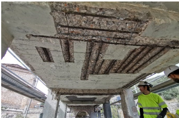
Figura 10. Reparaciones en cara inferior de tablero
