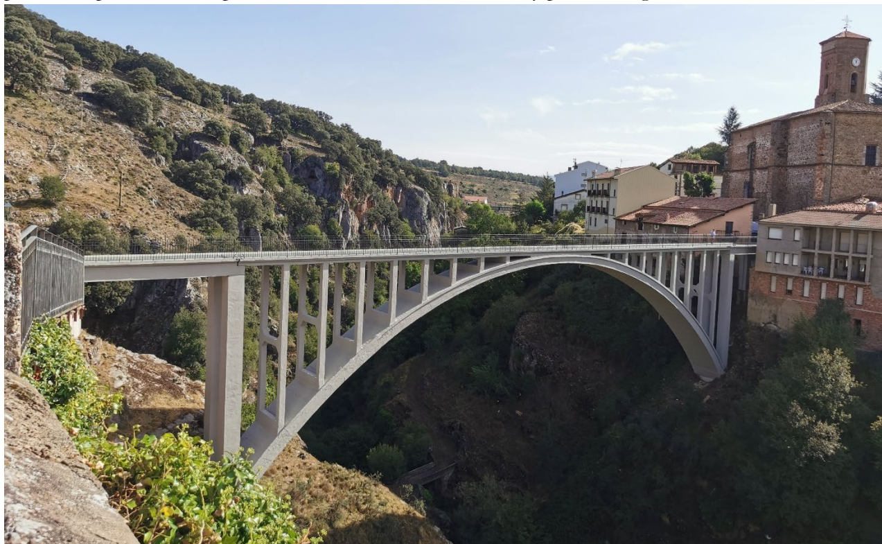
Figura 3. Vista general acabada la rehabilitación integral
