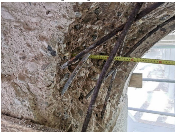
Figura 8. Espesor de reparación de 40 cm en la parte superior de pila P2
