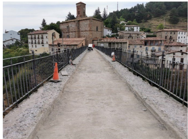
Figura 11. Aspecto del tablero una vez retirado el relleno y saneadas las vigas-acera
