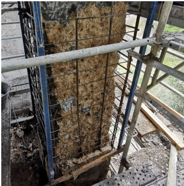
Figura 7. Pila saneada y con armadura repuesta previa a la aplicación del mortero
