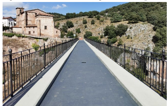
Figura 12. Vista del tablero acabado
