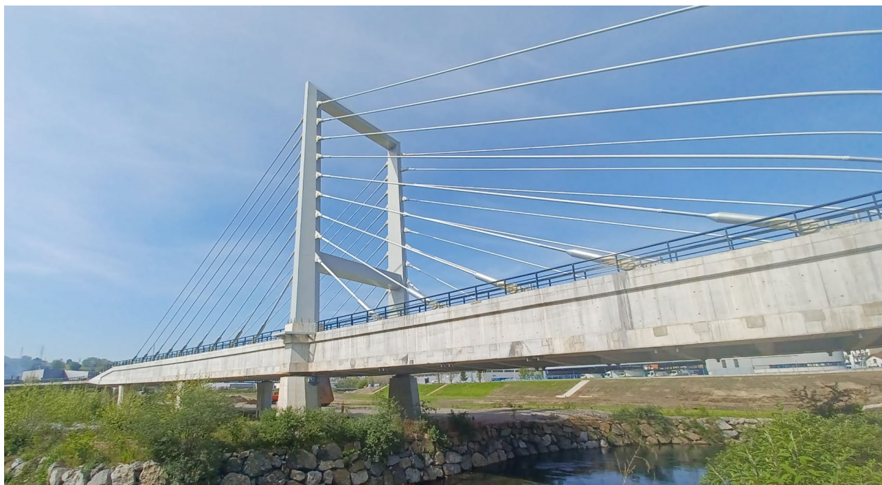
Figura 19. Vano atirantado sobre el río Urumea.
