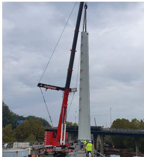
Figura 17. Montaje de mástil en obra.
