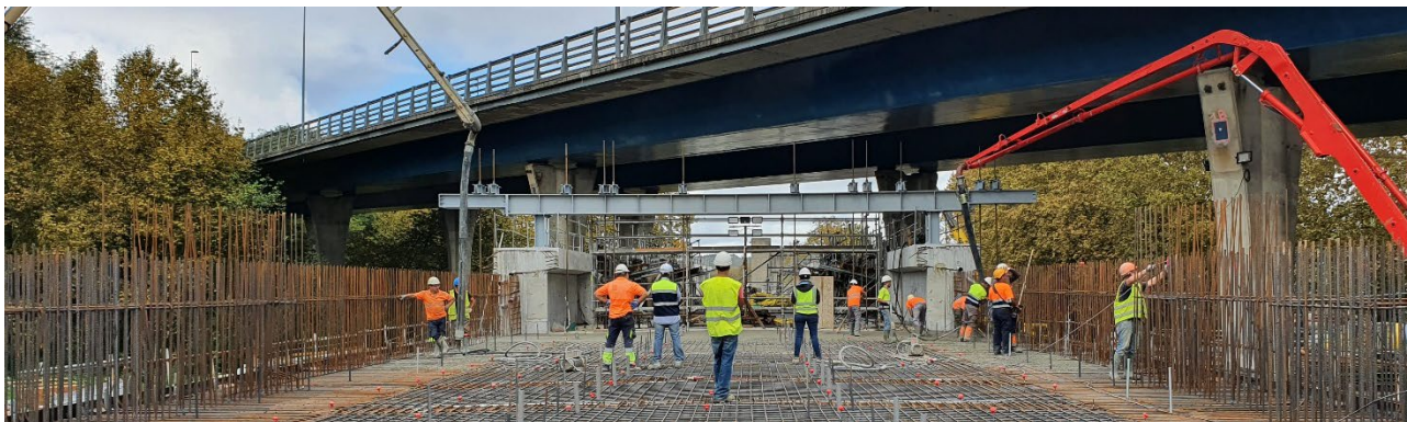
Figura 15. Hormigonado de losa de tablero, se aprecia el frente de fase anterior y la viga de cuelgue de la cimbra.
