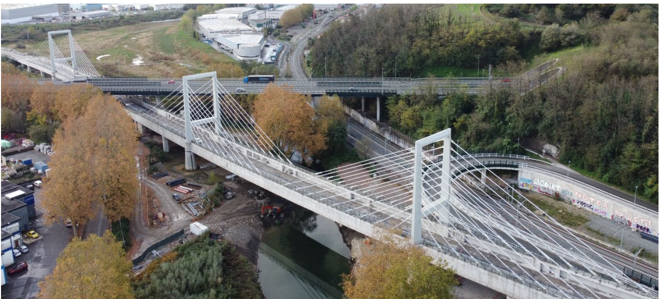
Figura 1. Vista del Tramo Central del Viaducto de Hernani.
