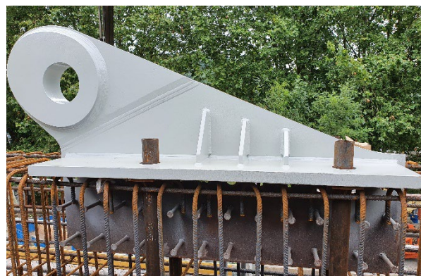
Figura 7. Orejeta de anclaje al tablero.
