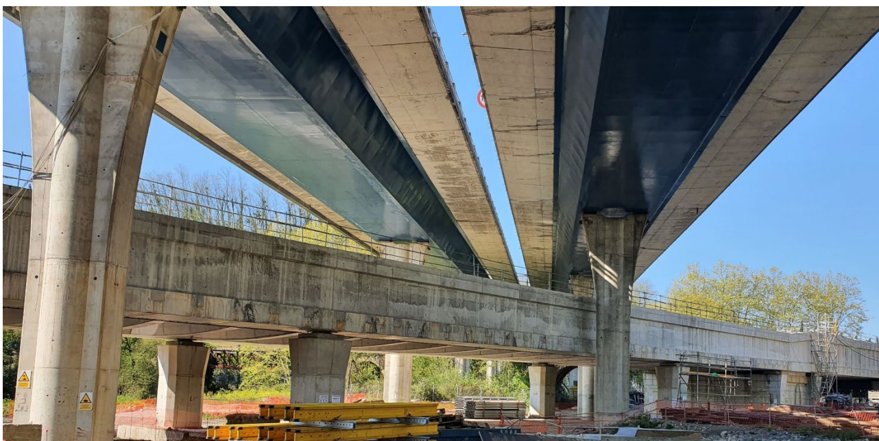
Figura 4. Paso bajo el tablero y entre las pilas del viaducto de autovía existente.
