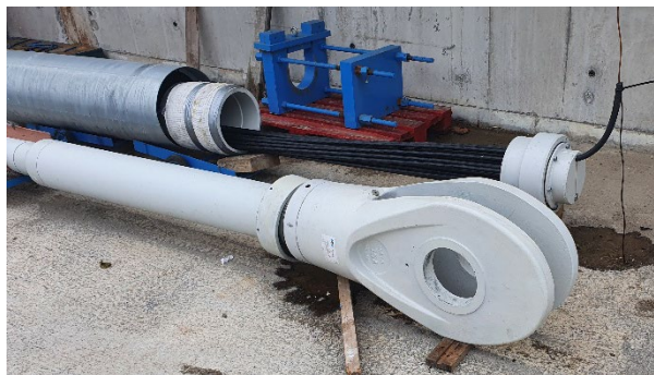
Figura 9. Mazarota de anclaje de tirante.
