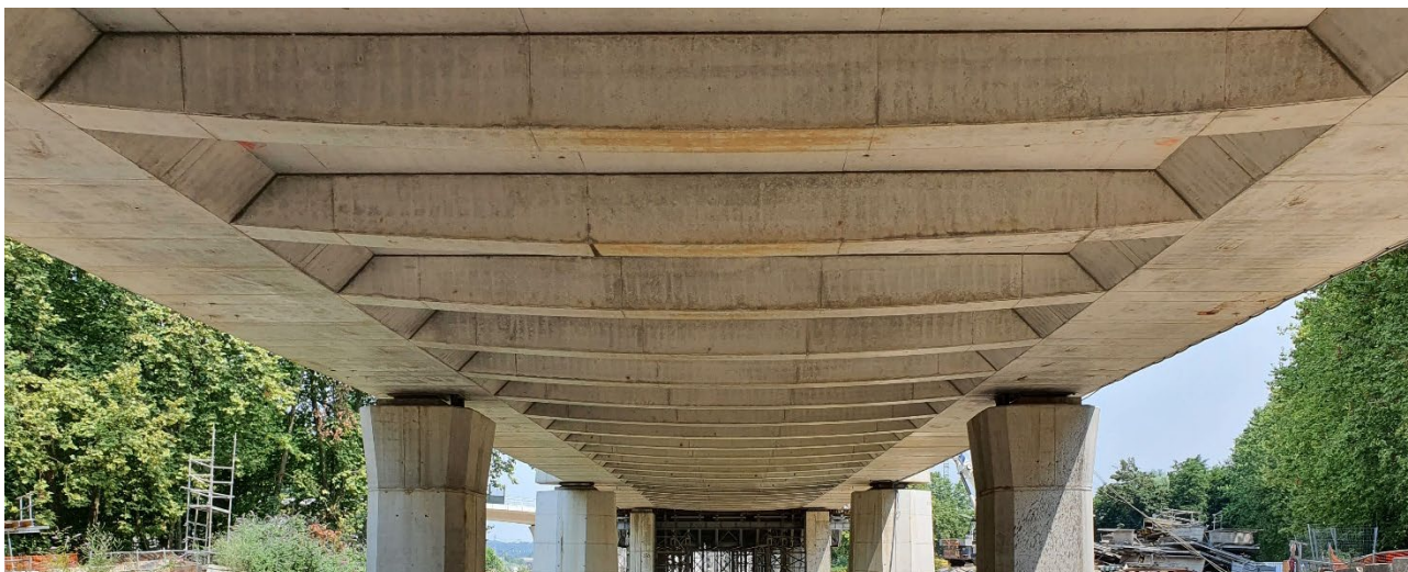
Figura 3. Vista de la cara inferior del tablero con las costillas transversales.
