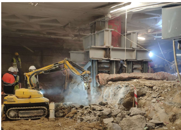
Figura 7: Pilar apeado. Zapata en proceso de demolición
