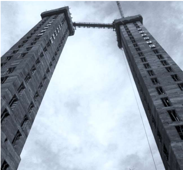
Figura 1. Núcleos de hormigón en proceso de ejecución.
