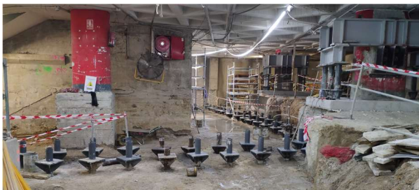
Figura 8. Fase de replanteo de armado
