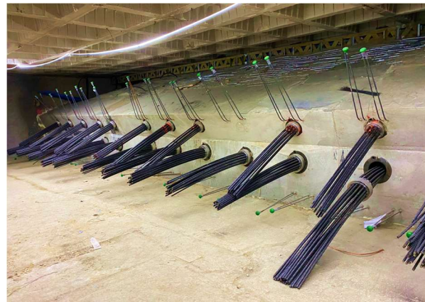
Figura 10. Fase de tesado y finalización.
