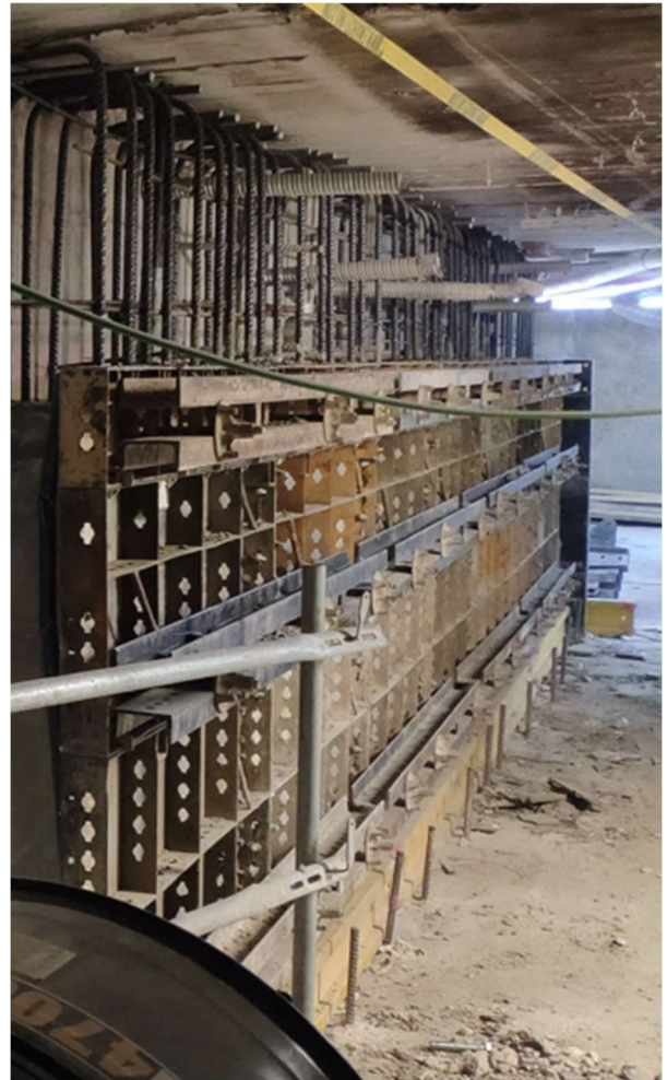
Figura 19. Fase de encofrado de refuerzo de muro de núcleo.
