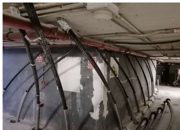
Figura 16. Coronación de vainas y armado activo.
