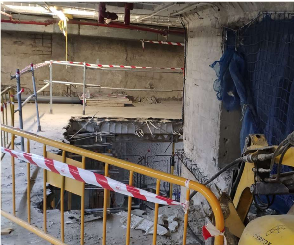
Figura 17. Fase previa de demolición de forjado.
