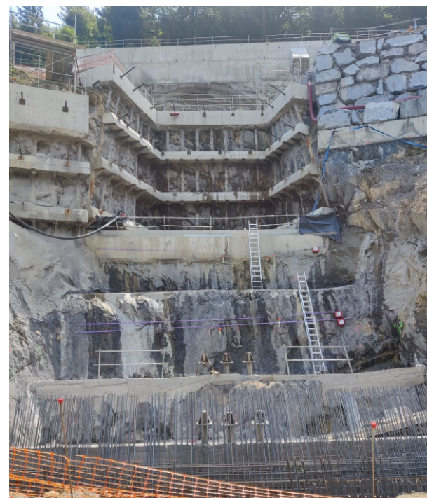
Figura 4. Recinto de excavación
