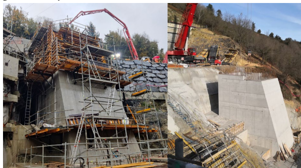
Figura 6. Ejecución del alzado del estribo
