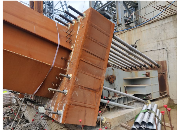
Figura 28. Sistema de empotramiento en arranque
