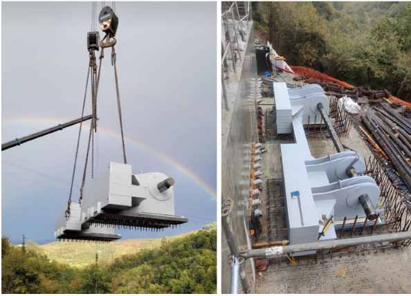
Figura 8. Montaje de rótulas
