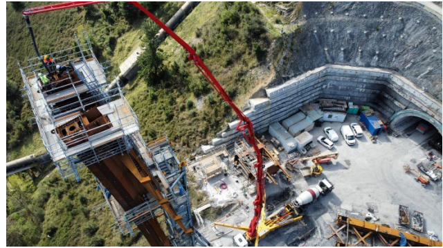
Figura 13. Bombeo de hormigón al interior del tramo
