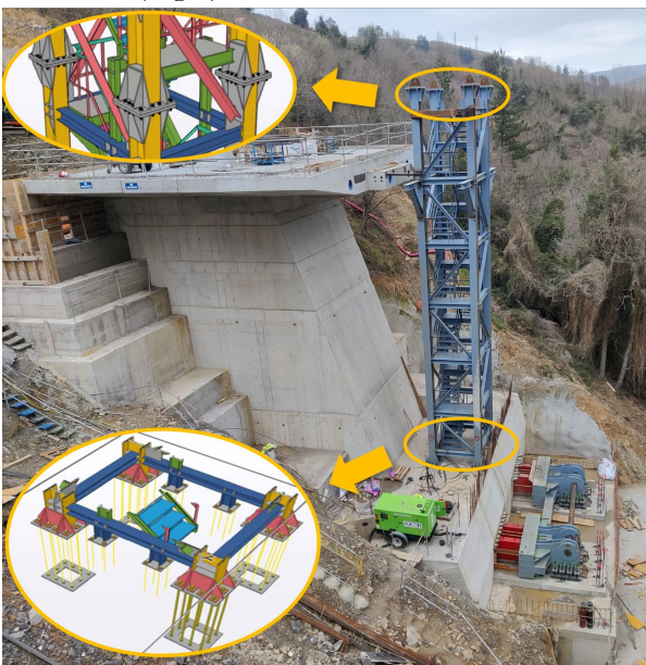
Figura 9. Primer tramo de torre auxiliar anclada a estribo y rótulas instaladas
