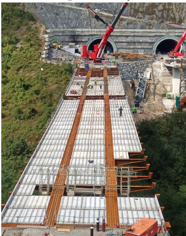
Figura 31. Instalación de prelosas
