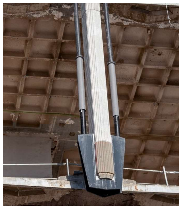
Figura 5: Anclaje inferior de los nuevos postesados
