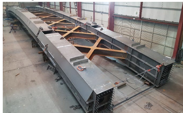
Figura 7. Fotografía de armado de tramo de arco
