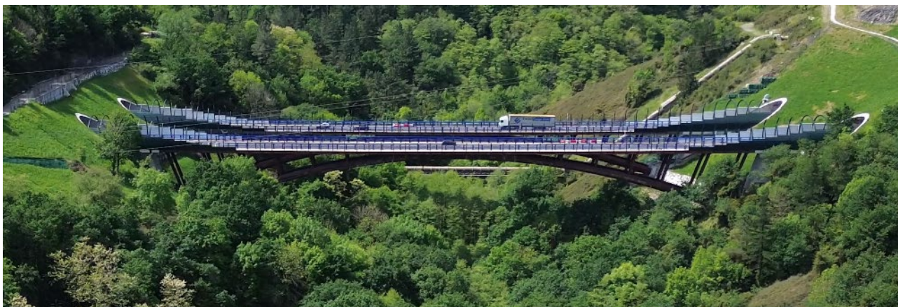
Figura 23. Fotografía de estructura acabada
