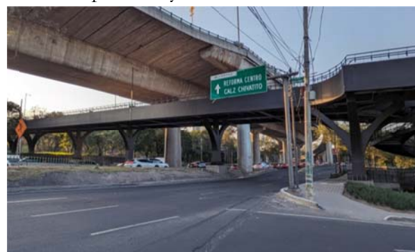
Figura 15. Cruce entre los dos niveles de Periférico.
