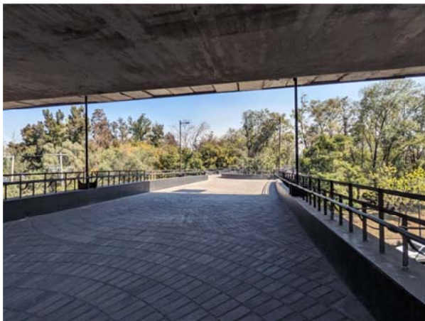
Figura 16. Paso bajo el viaducto de Periférico.
