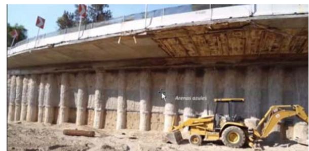
Figura 19. Estratigrafía de la zona durante las antiguas obras de depresión del Anillo Periférico.
