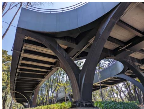
Figura 11. Encuentro pila-tablero (Chapultepec).
