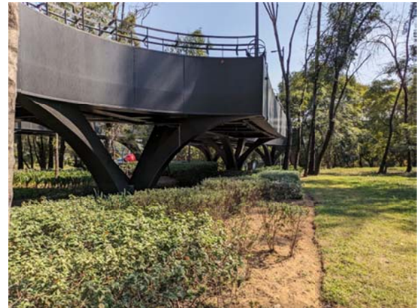
Figura 8. Tramo con pilas bajas.
