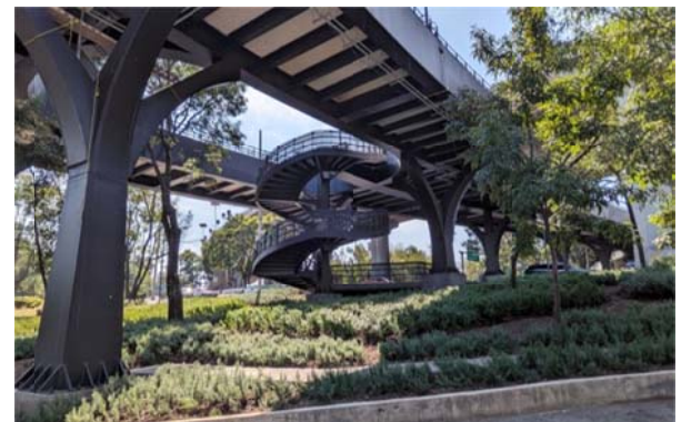
Figura 9. Escalera helicoidal en óculo de Chivatito.
