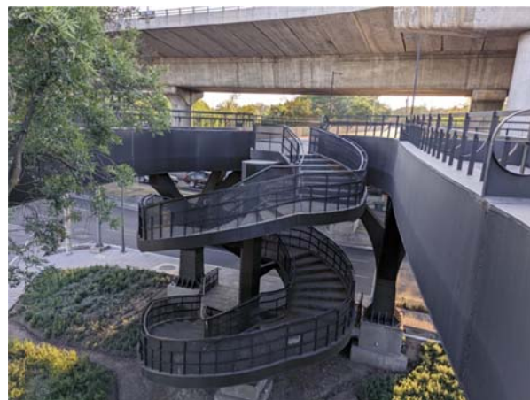
Figura 32. Vista general de la escalera.
