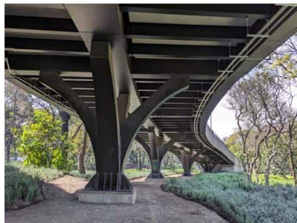
Figura 12. Encuentro pila-tablero (Chivatito).
