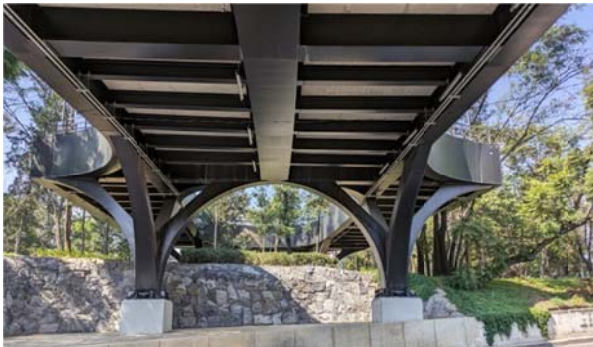
Figura 6. Transición de sección tipo a óculo.
